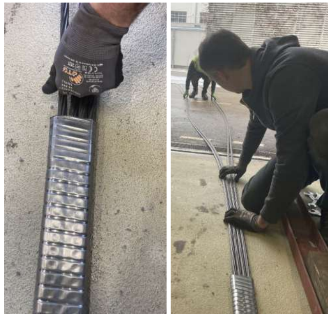
Abb. 4.16: Einführen der Spannglieder in die Hüllrohre
