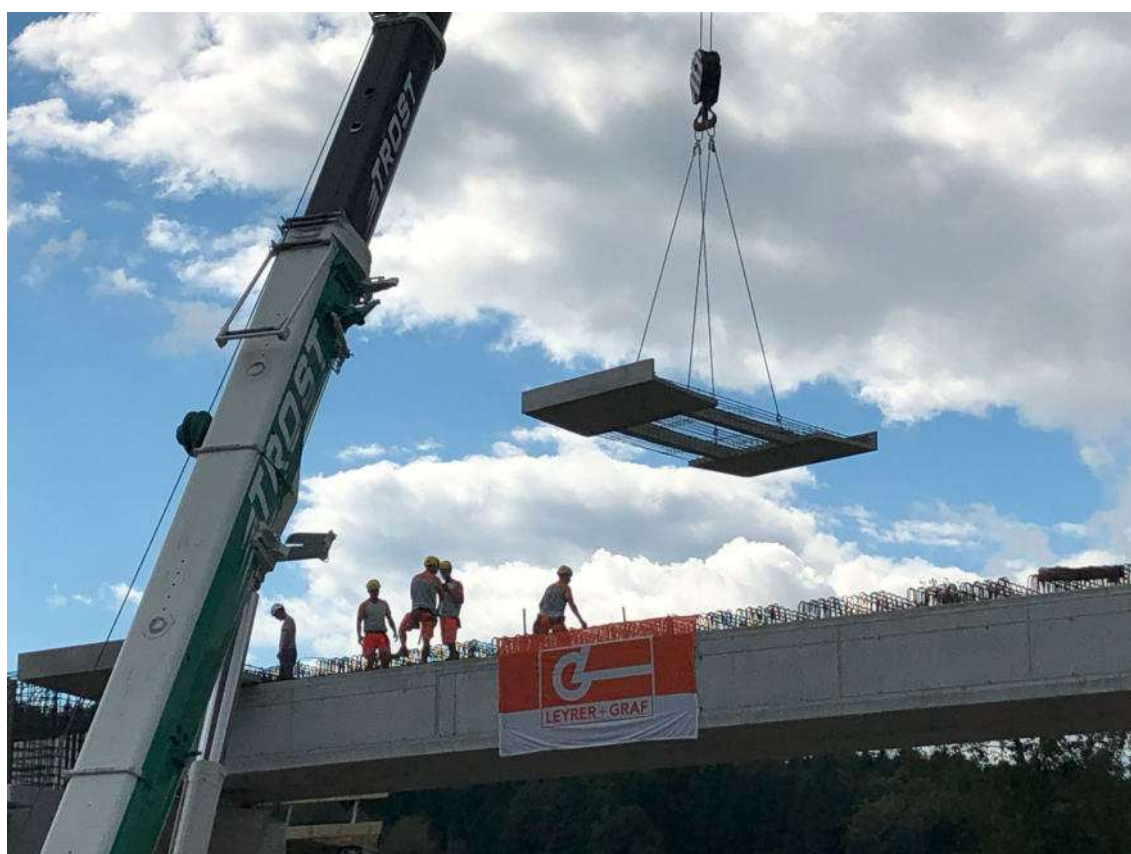
Abb. 3.6: Einheben eines der Fahrbahnplattenelemente für die Pinkabachbrücke aus [4] (Foto: TU Wien).
