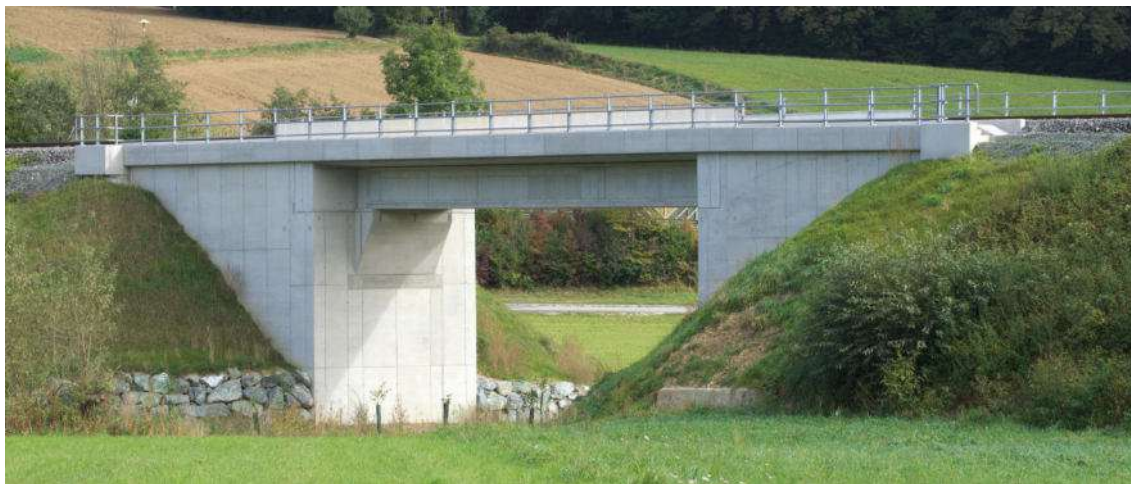
Abb. 3.5: Pinkabachbrücke aus [4] (Foto: Fabian Fritz).
