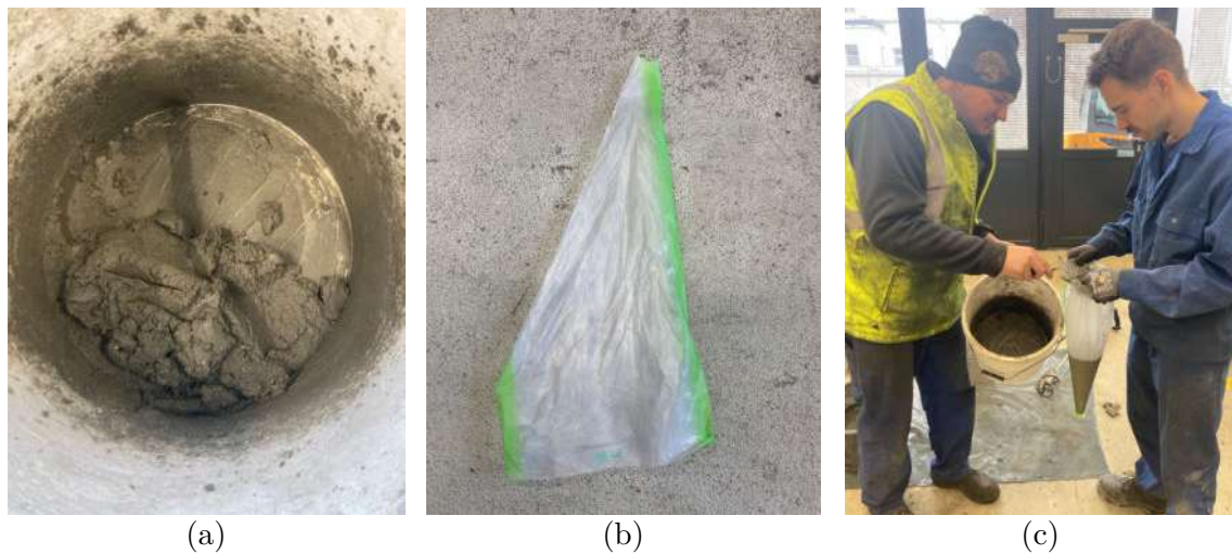
Abb. 5.4: Vorbereitungen für die Herstellung der Mörtelfuge: (a) Angemischter PCC-Betonreparaturmörtel ARDEX B 16, (b) Spritzsack zum Aufbringen des Mörtels und (c) Einfüllen des Mörtels in den Spritzsack
