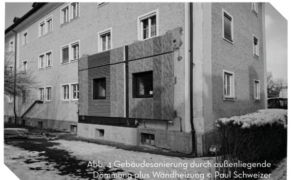
Abb. 4 Gebäudesanierung durch außenliegende Dämmung plus Wandheizung © Paul Schweizer
