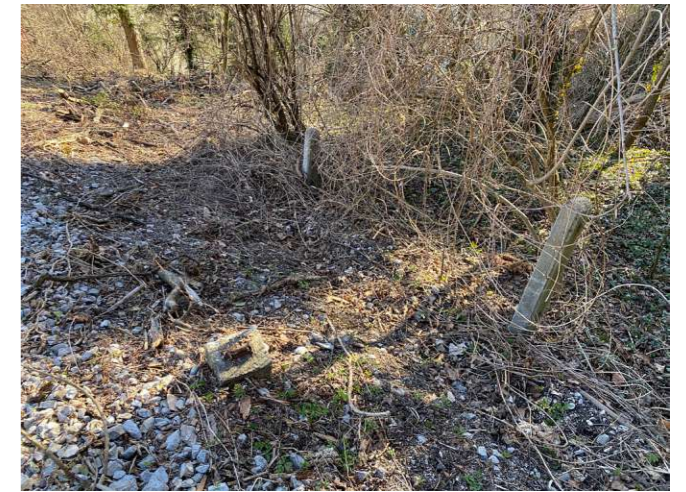
Abb. 28 Kiesbett und Restbestand der Gleisaufbauten
