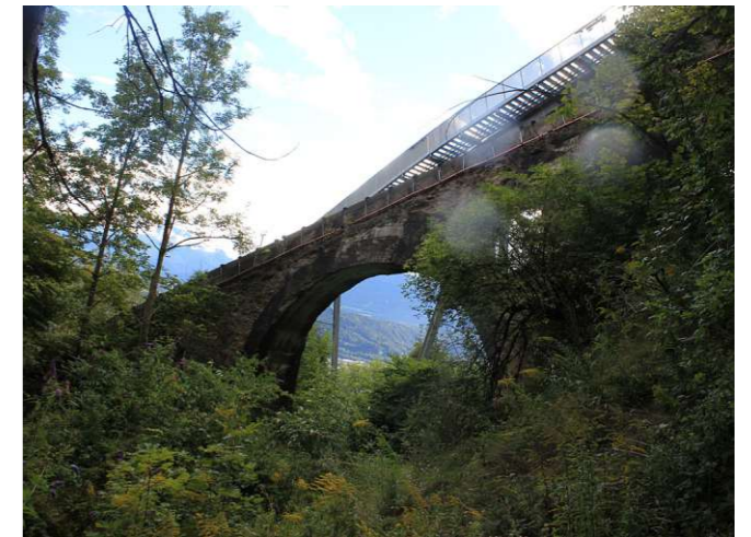
Abb. 42 Neue Trasse schwenkt in alte Trassenführung ein
