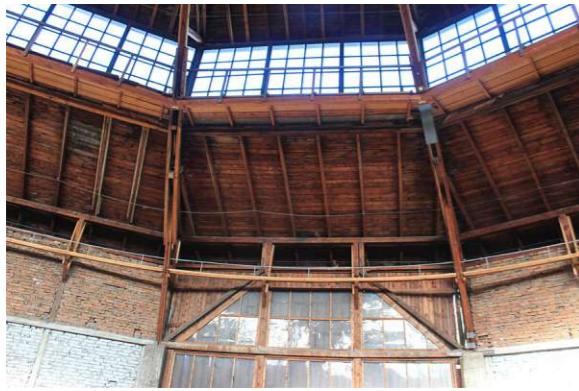
Abb. 54 Rotunde, Fenster, Dachkonstruktion, 360° Sprossenfenster
