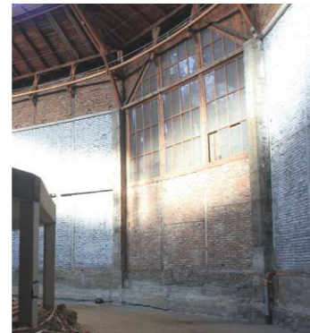
Abb. 73 verdecktes Fenster, Richtung Fluss
