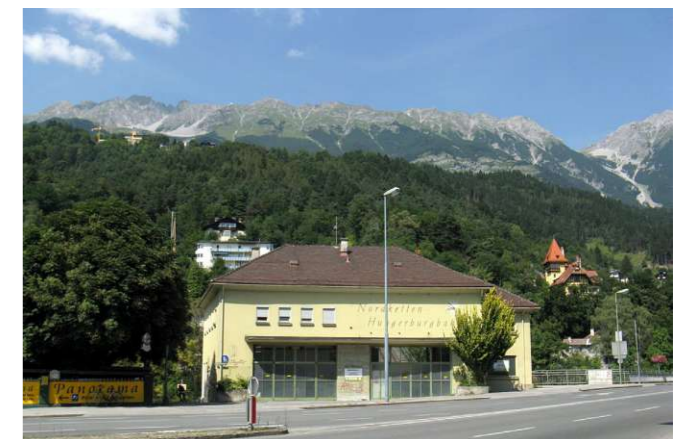
Abb. 20 Talstation nach der Stilllegung, 2008
