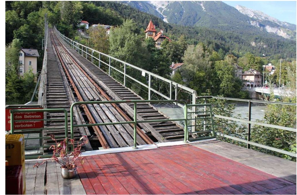
Abb. 63 Talstation, überbaute Terrasse über ehemaliger Bahntrasse
