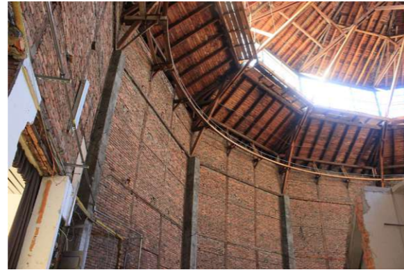
Abb. 57 Rotunde, Eingang, Dachkonstruktion, 360° Sprossenfenster
