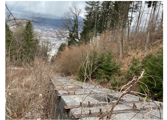
Abb. 40 Blick auf Wegführung auf dem Viadukt
