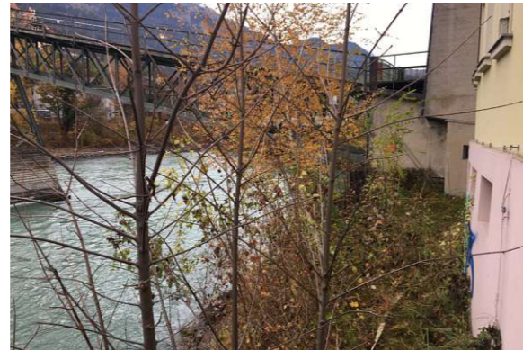
Abb. 67 Talstation Flusseite, Blick Richtung Abfahrtshalle
