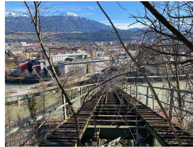
Abb. 27 Blick auf Eisenbrücke Richtung Talstation
