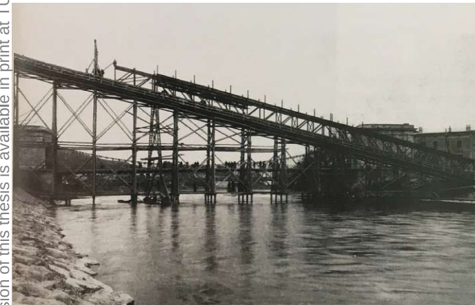
Abb. 15 Bauarbeiten Hungerburgbahn, Lehrgerüst der Innbrücke, April 1906
