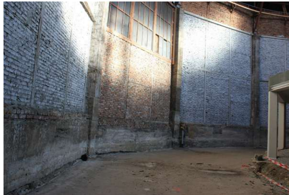
Abb. 49 Rotunde, Ziegelmauerwerk, Abbruch Boden
