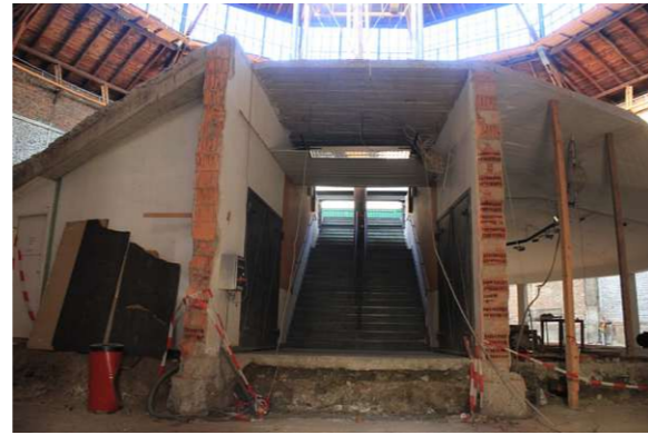
Abb. 50 Rotunde, Aufgang Podest, Abbruch Boden und Wände
