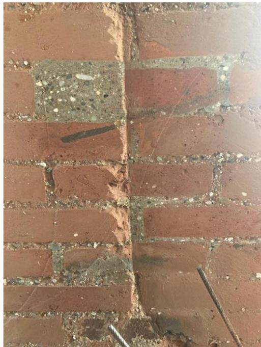
Abbildung 10: Querschnitt durch ein Mauerwerk mit sichtbaren verbleibenden Packern<sup>59</sup>
