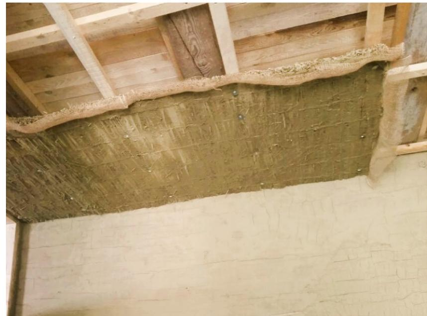
95 FOTO: DECKE MIT MONTIERTER SCHILFROHR-LEICHTBAUPLATTE, EINGESCHLÄMMT UND VLIES ALS ARMIERUNG DER STOßFUGEN
