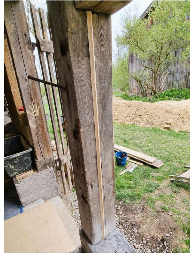
73 FOTO: DREIECKSLEISTEN SEITLICH MONTIEREN. DIESE WERDEN MIT EINGEPUTZT
