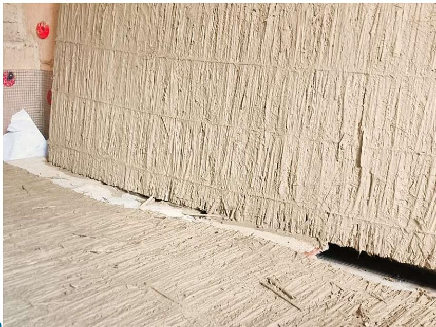
94 FOTO: SCHILFROHR-LEICHTBAUPLATTE IN LEHMSCHLÄMME
