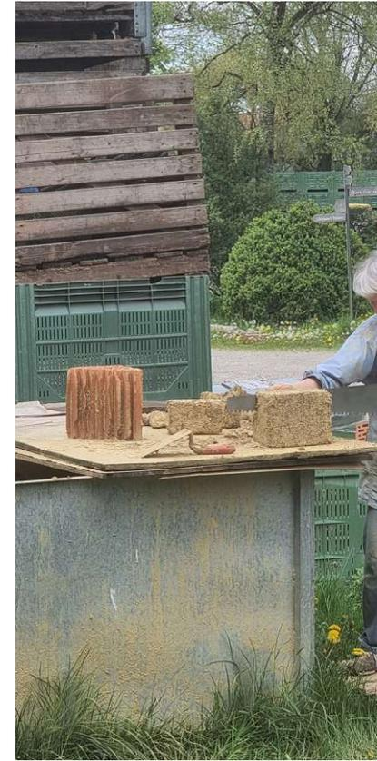
74 FOTO: LEICHTLEHM-STEINE LASSEN SICH MIT DER GASBETON-SÄGE ZUSCHNEIDEN
