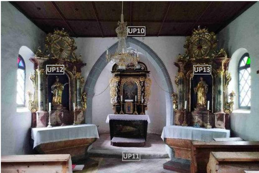
Verputztes Steinmauerwerk, das durch einen spitzbogigen Triumphbogen den Chorraum vom Langhaus trennt. Farbige Absetzung des Triumphbogens.
