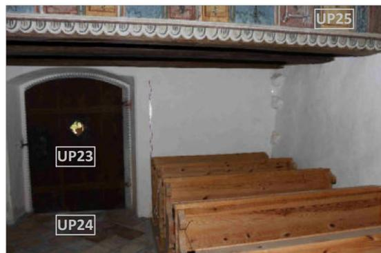
Verputztes Steinmauerwerk mit der Hauptzugangstüre im Erdgeschoß sowie einer kleinen Fensteröffnung auf Höhe der Empore.
