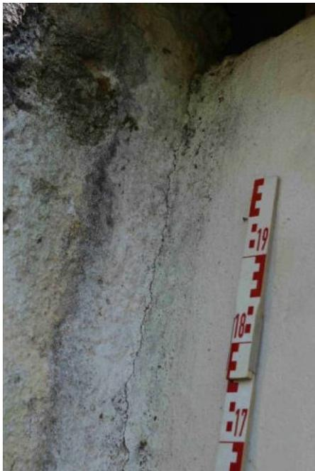
Abbildung 13, Setzriss zwischen Vorlaube und Schiff, Nordseite
