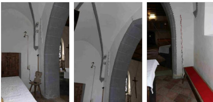
Verputztes Steinmauerwerk, das durch einen spitzbogigen Triumphbogen den Chorraum vom Kirchenschiff trennt. Farbige Absetzung des Triumphbogens.
