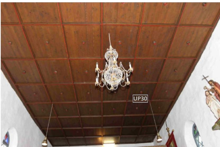
Von den Bundträmen des Schiffsdachwerkes abgehängte Nut-und-Feder Bretter, mit aufgesetzten Leisten zum Anschein einer flachen Kassettendecke verziert.
