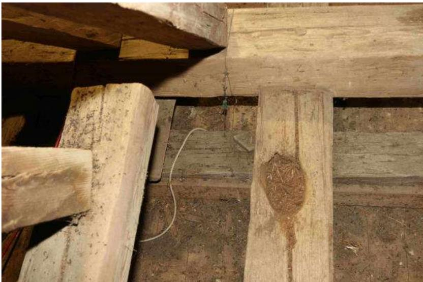
Längsunterzug UP02, Wasserschaden, Ansicht von Westen
