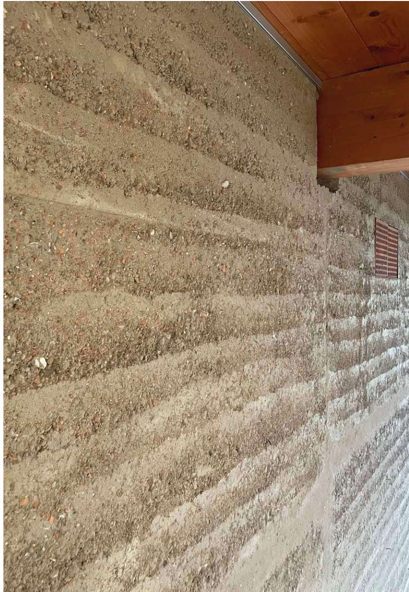
Abb.12: Detail Lehmwand Träger
