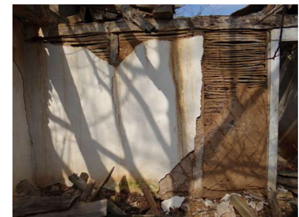
Abb.18 Holzskelletwand mit darauf genagelten Holzlatten
