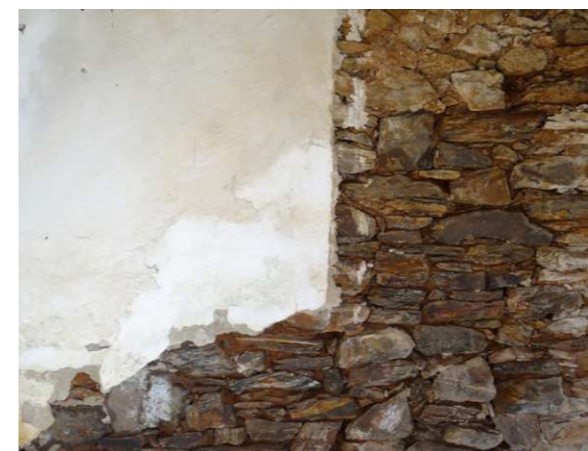
Abb.15 Steinwand mit Putz
