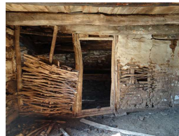
Abb.17 Holzskelletwand mit Füllung aus geflochtenen Holzstäbchen
