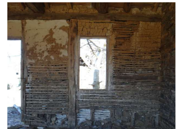
Abb.16 Holzskelletwand mit Steinfüllung
