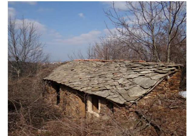
Abb.14 Dach mit Tikli (Steinplatten)
