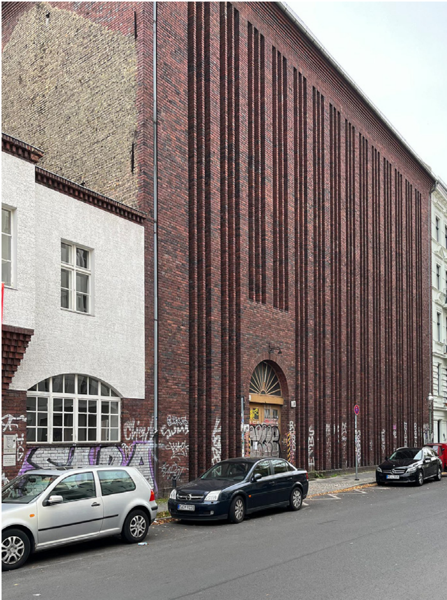
Abb. 6.4.: Stützpunkt Richardstraße, TW 2021
