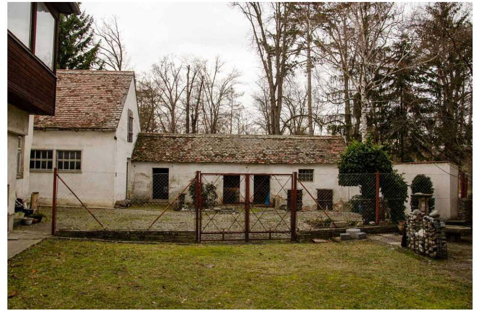
Abb.133.: Foto Leidenfrostmühle Nebengebäude Stallungen
