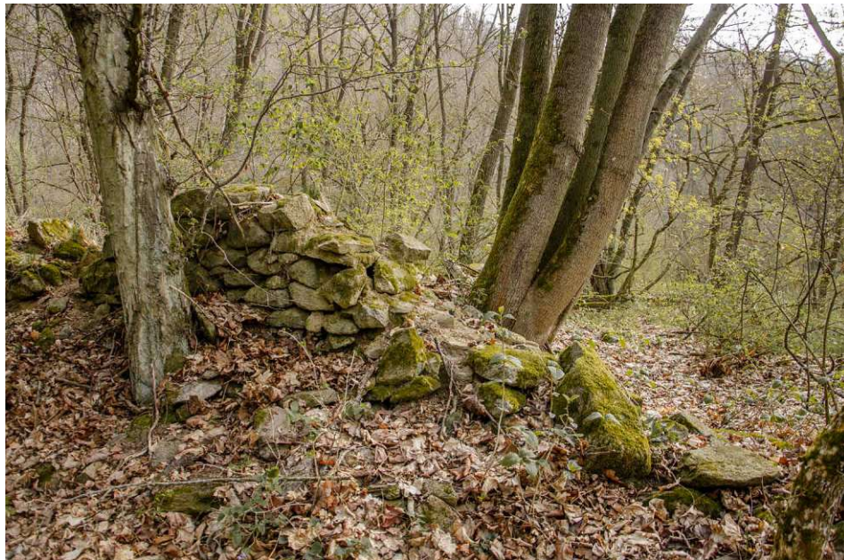
Abb.42.: Foto Mauerwerk unterhalb der Ruine Neudegg
