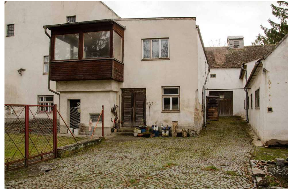
Abb.134.: Foto Leidenfrostmühle Anbau Maschinenhaus
