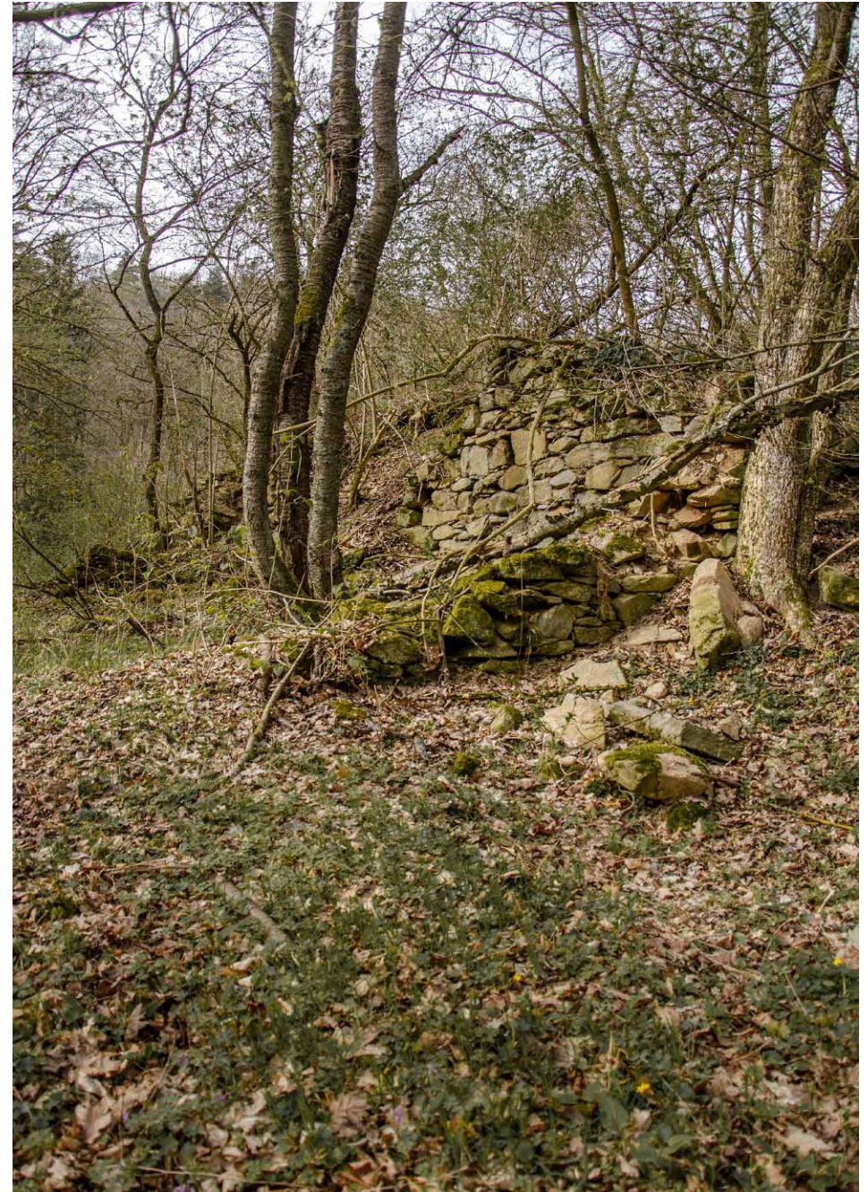
Abb.44.: Foto Mauerwerk unterhalb der Ruine Neudegg
