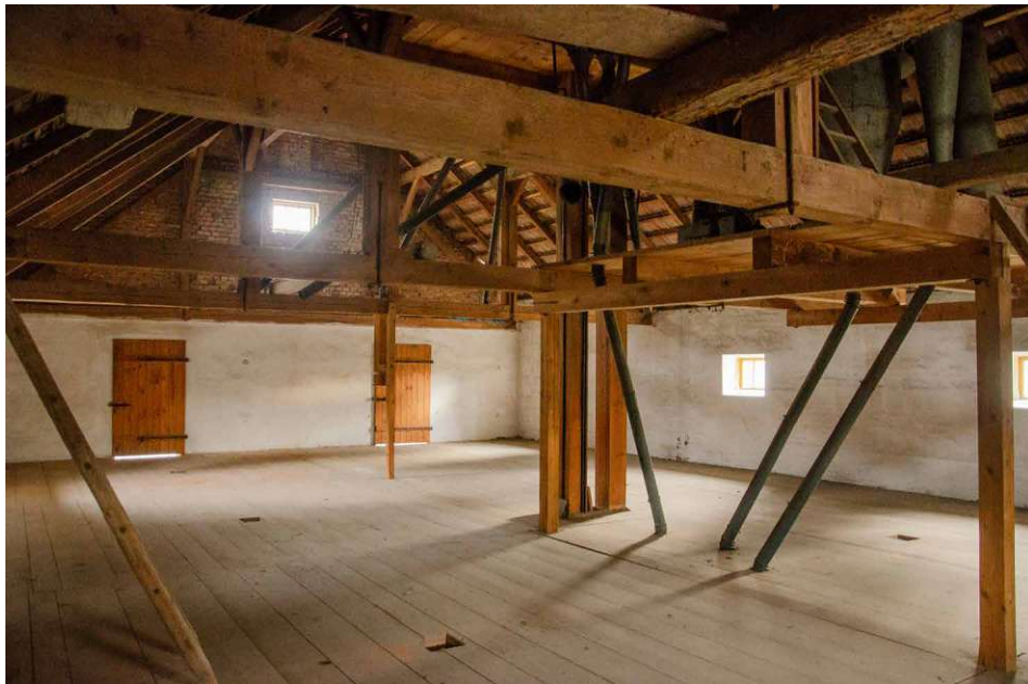
Abb.136.: Foto Leidenfrostmühle Neubau Schüttboden DG
