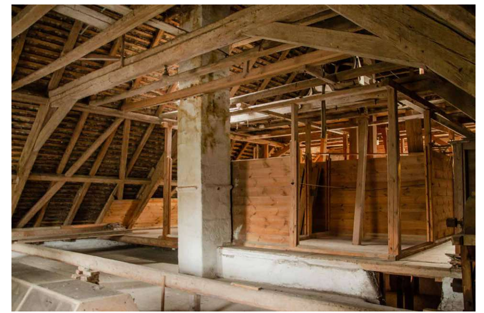
Abb.138.: Foto Leidenfrostmühle Hauptgebäude Schüttboden DG
