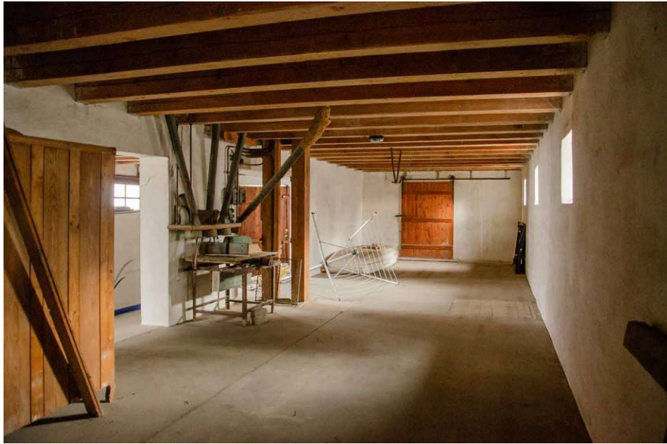
Abb.135.: Foto Leidenfrostmühle Neubau Schüttboden OG
