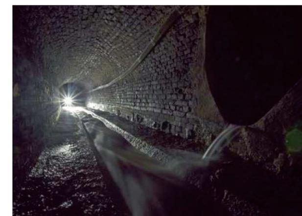
Abb. 176: Kanalisierung Ottakringerbach
