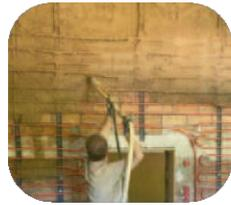
Die Wand wird einst vermutlich aus Lehm- und Feldsteinen aufgebaut gewesen sein. Der Umbau in den 70ern ersetzte sie durch eine Mauerwerkswand. Nun wird sie mit einer Wandheizung versehen und mit dem ursprünglichen Material Lehm verputzt und wird dann für eine gute Raumlufffeuchte und Speichermasse sorgen.
