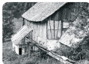
die Balken im Dachtragwerk, sowie im Obergeschoss reichen bis zu dieser Stelle und sind ab hier angestückelt, das lässt darauf schließen, dass der Hof einmal hier endete
