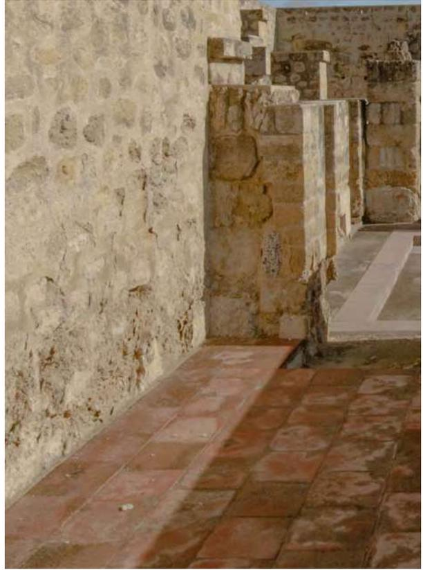
**Abb. 3.63** Detail eines mit Ziegeln gepflasterten rekonstruierten Bodens
