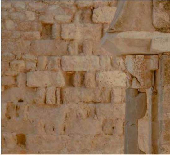
**Abb. 3.62** Detail eines Mauerverbandes und einer abgebrochenen Stütze
