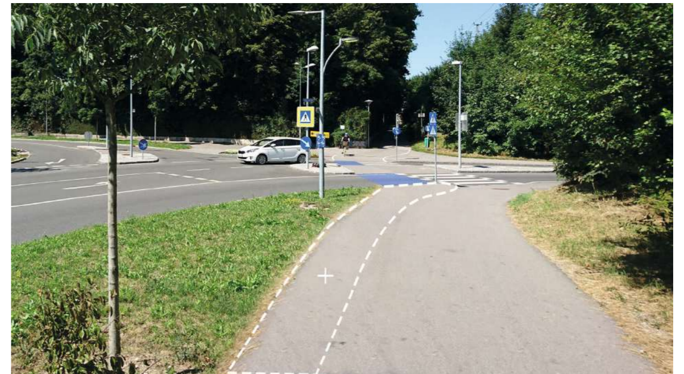
Abb. 61: Kreuzung Eybnerstraße / Westbahnallee, Blick nach Süd-West, nachher symbolische Darstellung, Fahrradspur sollte > 2,5m breit sein Darstellung mit Markierungen um Aufmerksamkeit und Sicherheit zu erhöhen
