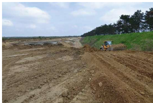
Abb. 2.15 | Bodenaushubdeponie, Verfüllung
