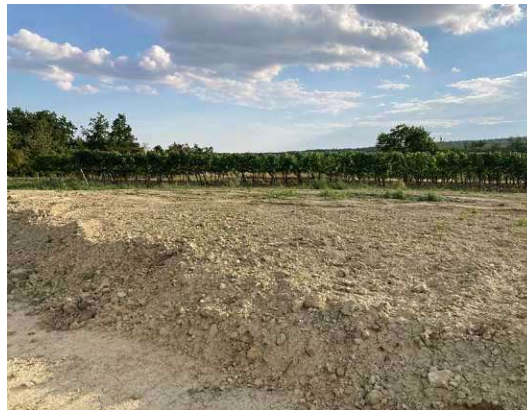
Abb. 2.11 | Aushubaufschüttung als Geländeanpassung auf landwirtschaftlicher Fläche
