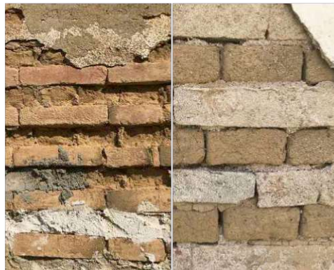
Abb. 1.07 | Gemischtes Mauerwerk
