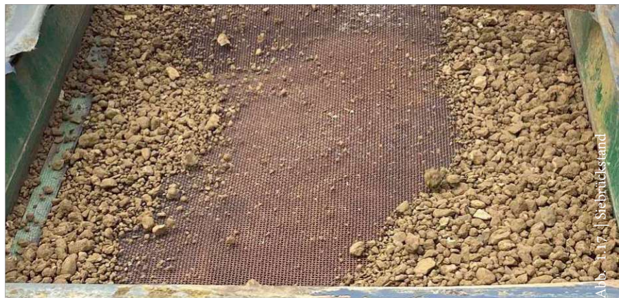
Abb. 1.15 | Siebung des Aushubs
