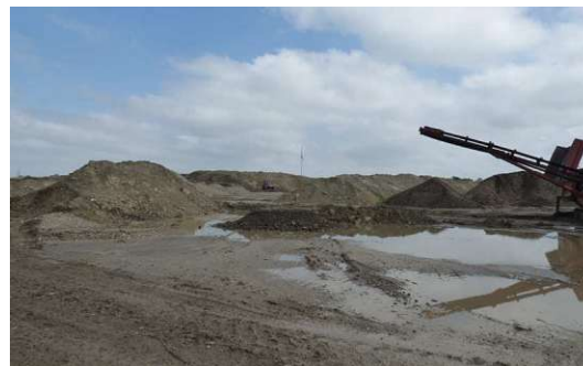
Abb. 1.01 | Ablagerung von Baustellenaushub
