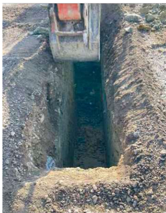
Abb. 4.24 | Schurferstellung
