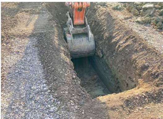
Abb. 4.05 | Schurferstellung
