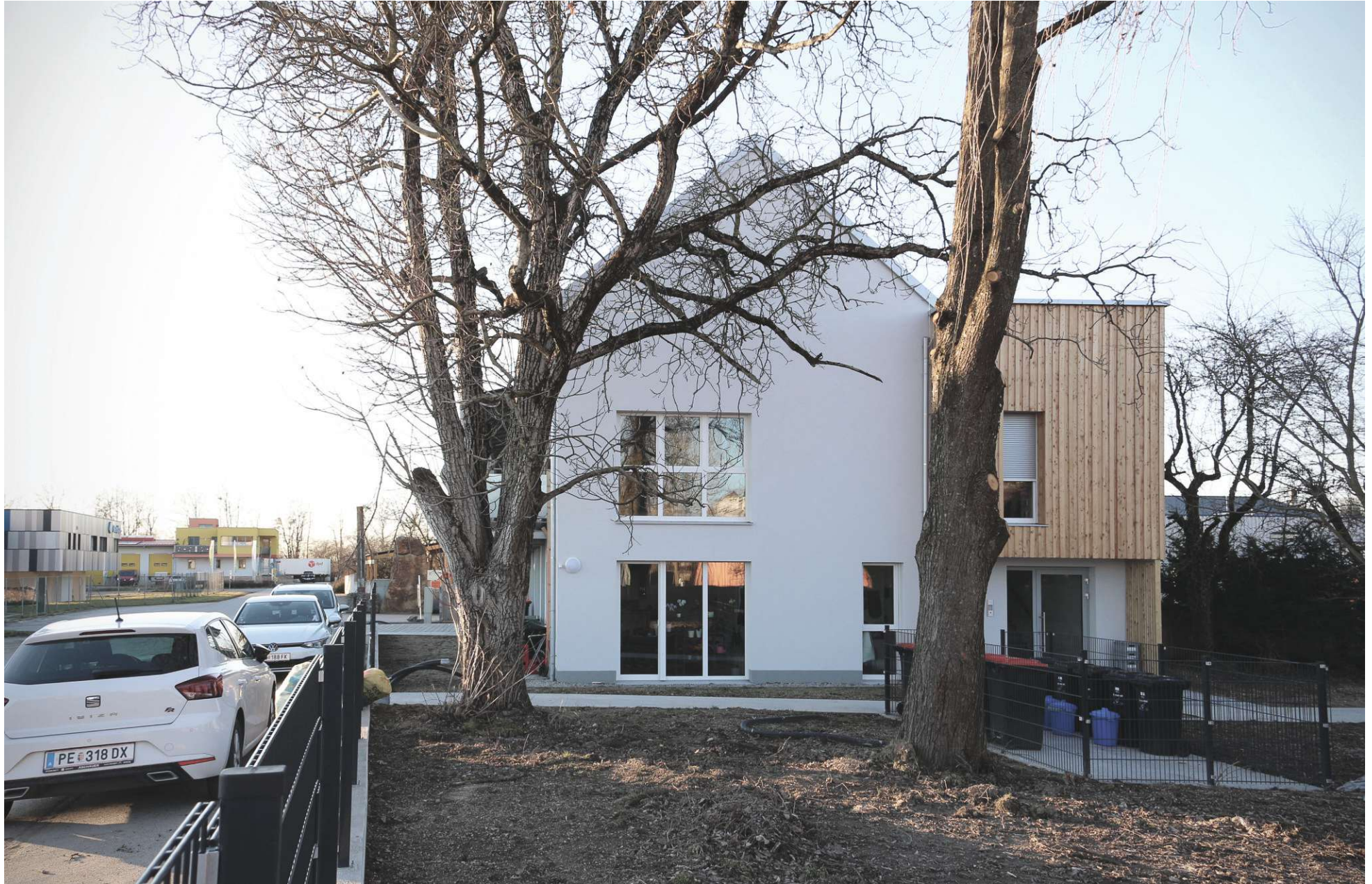
Abb.061 Ansicht Ost nach Sanierung (OÖ 2022)
