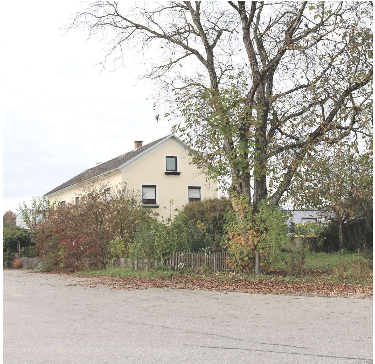
Abb.020 Ansicht Garten und Fassade Ost des Bestands (Arbing, OÖ, 2020) (eigene Abbildung)
