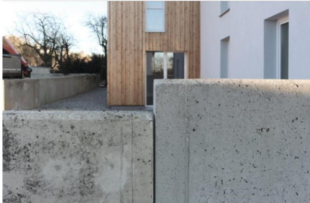
Abb.057 Sanierung Betonmauer (OÖ 2022)
