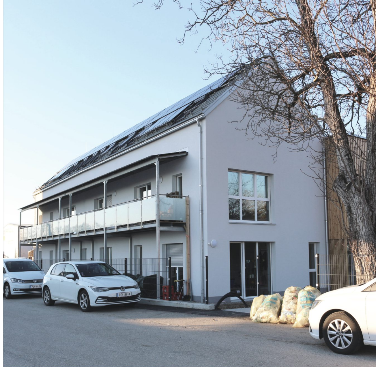
Abb.060 Ansicht Südost nach Sanierung (OÖ 2022)
