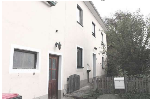
Abb.018 Fassade Süd des Bestands 2020 (eigene Abbildung)
