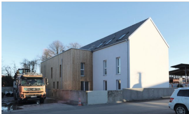
Abb.059 Ans. Nordwest nach Sanierung (OÖ 2022)
