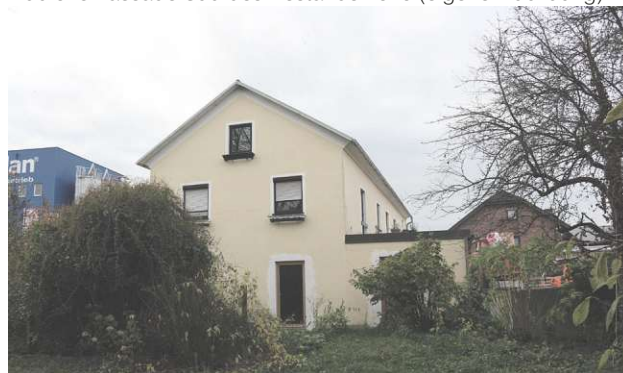
Abb.019 Fassade Ost des Bestands 2020 (eigene Abbildung)
