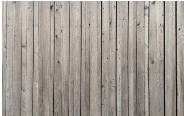
Lärchenholz Schalung vertikal, sägerauh
