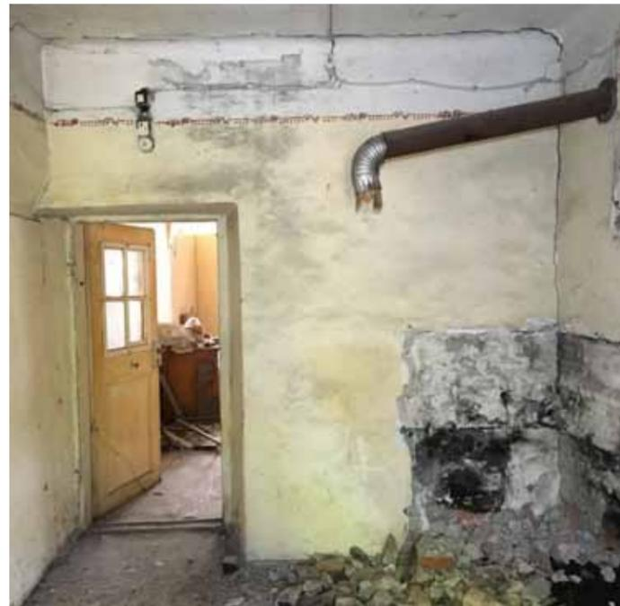
Abb. 147 rechteckige Tür in der Südwand zur Loggia OG.11 mit korbbogenförmigem Sturz
