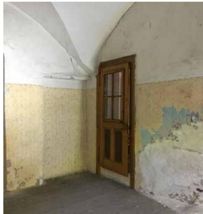
**Abb. 157** Blick nach Südosten; Wände mit sehr großen Putzfehlstellen
