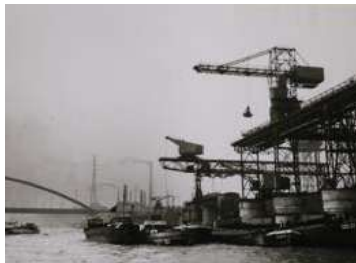
Fig. 69: Loading Zone of the Steelworks "Niederrheinische Hütte"
