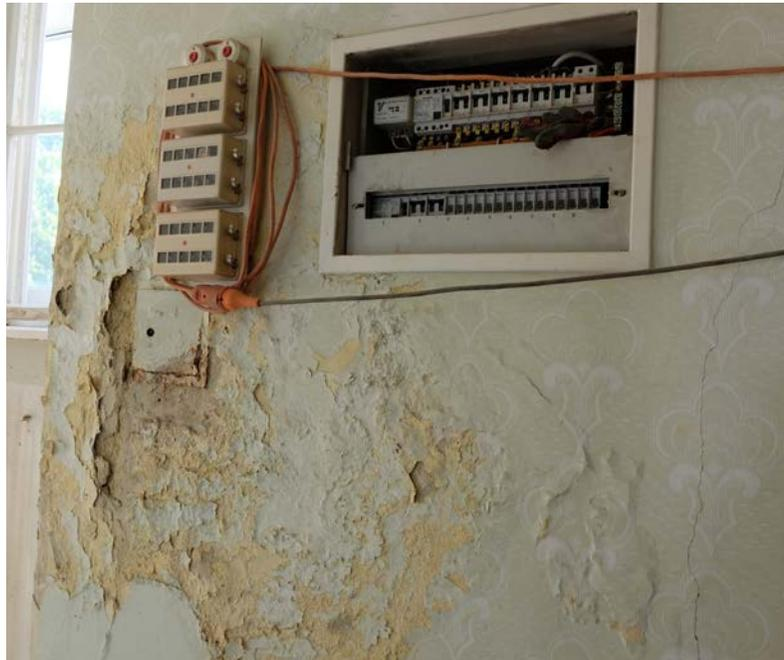
Abb. 428 Wasserschaden – Elektrokasten.
