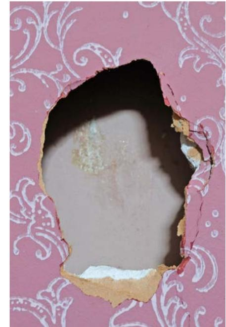
Abb. 245 Loch in vorgesetzter Wand.
