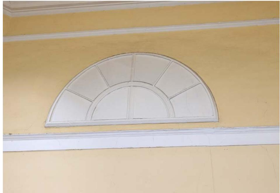
Abb. 264 Verblendetes Fenster zu Obergeschoss.
