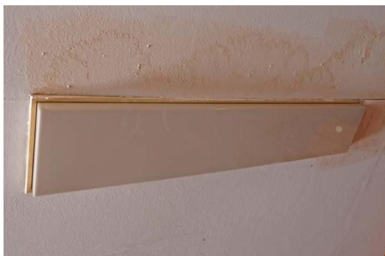
Abb. 303 Wasserfleck bei abgehängter Decke.
