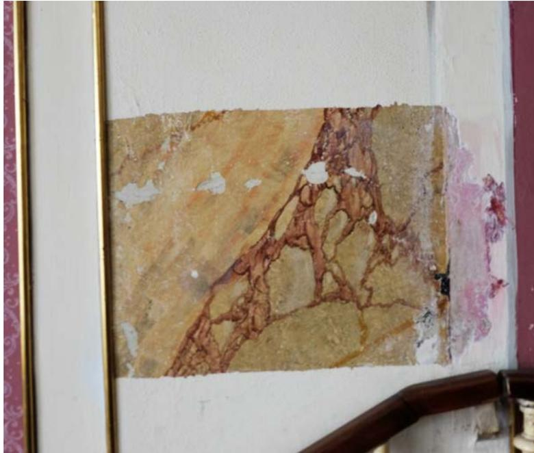
Abb. 247 Freilegung von Steinplatten auf Pilastern.
