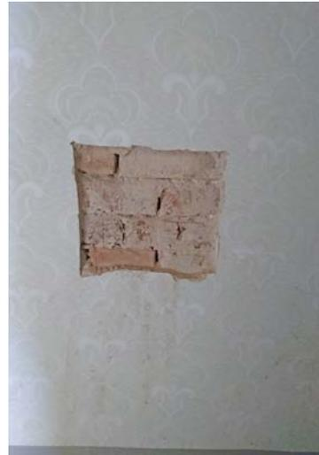
Abb. 380 Freigelegtes Mauerwerk.
