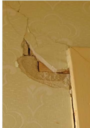
Abb. 477 Riss bei Türzarge.
