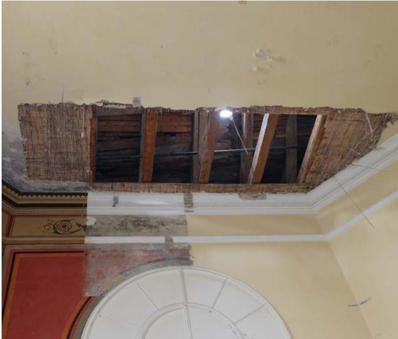
Abb. 266 Abgebrochene Decke.
