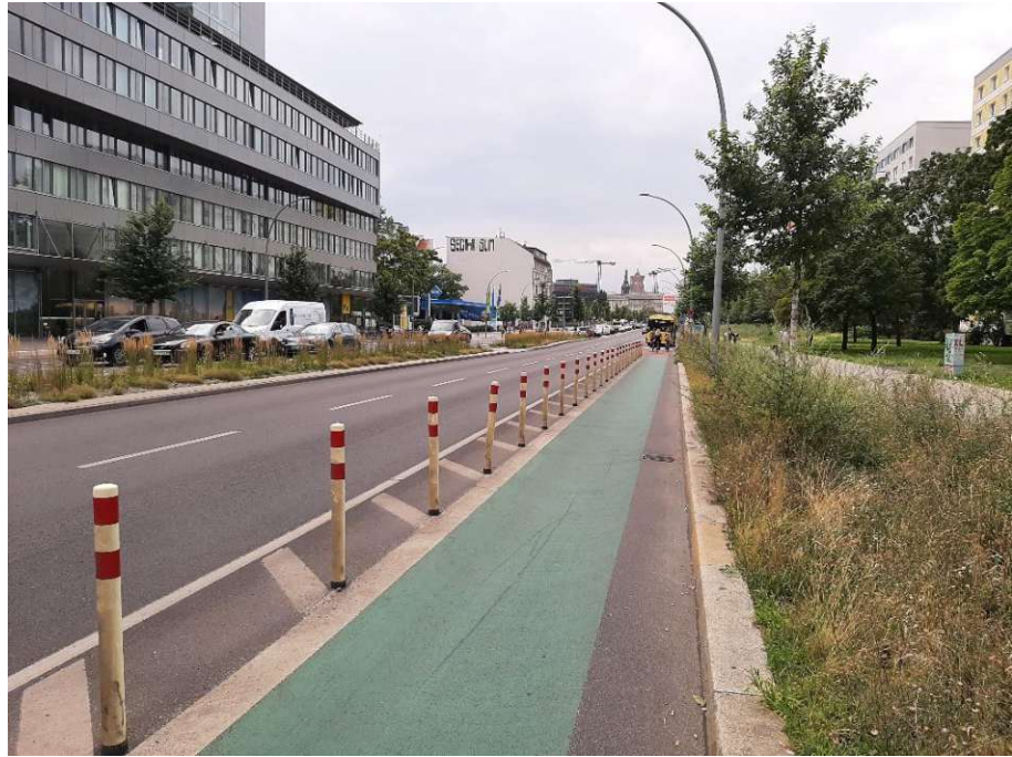
Abb. 32: Protected Bike Lane an der Holzmarktstraße 141
