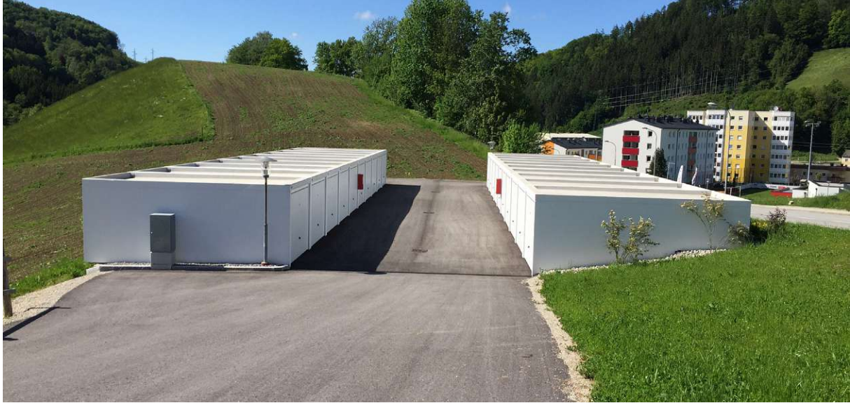
Abb. 43: Garagenanlage Böhlerwerk (eigene Aufnahme, 20.05.2021)
