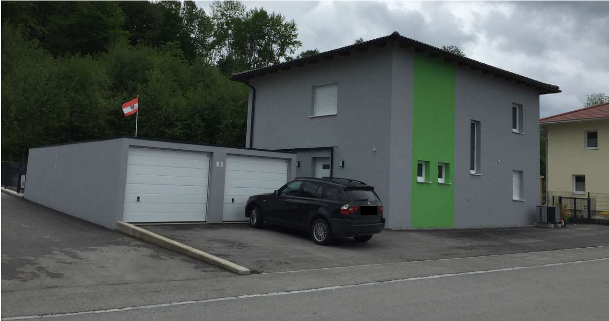
Abb. 57: EFH Sonnensiedlung (eigene Aufnahme, 20.05.2021)
