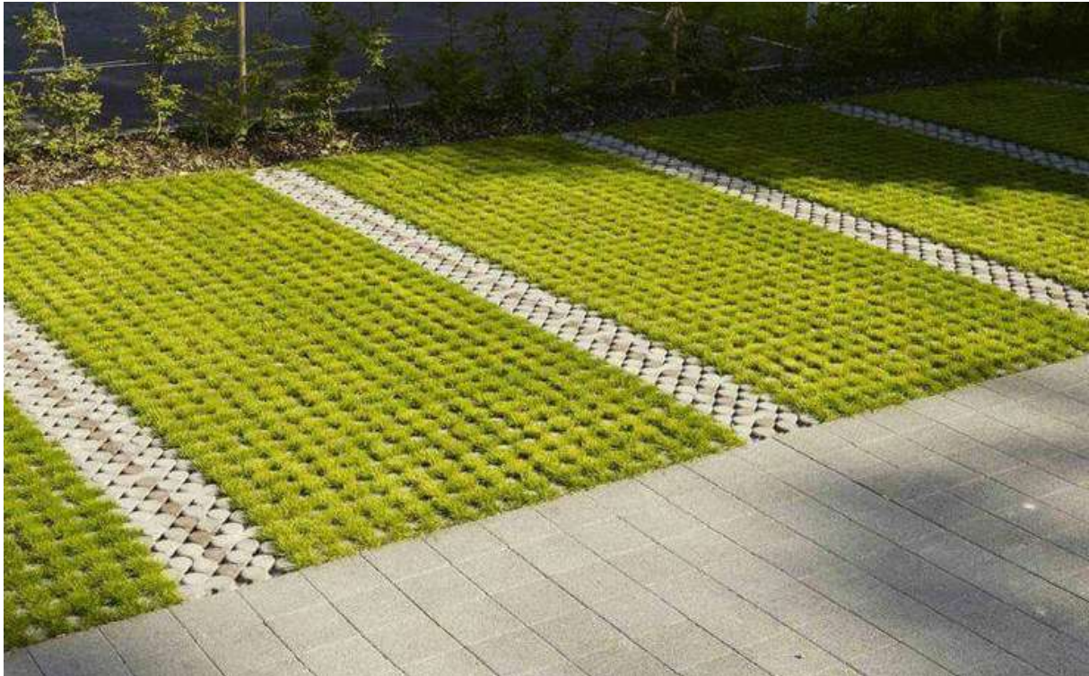
Abb. 59: Parkplatz mit Rasengittersteinen (Quelle: GTSM Magglingen AG o.J.)
