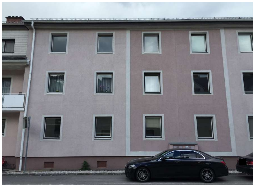
Abb. 33: teilweise leerstehender Gemeindebau Bruckbach (eigene Aufnahme, 20.05.2021)
