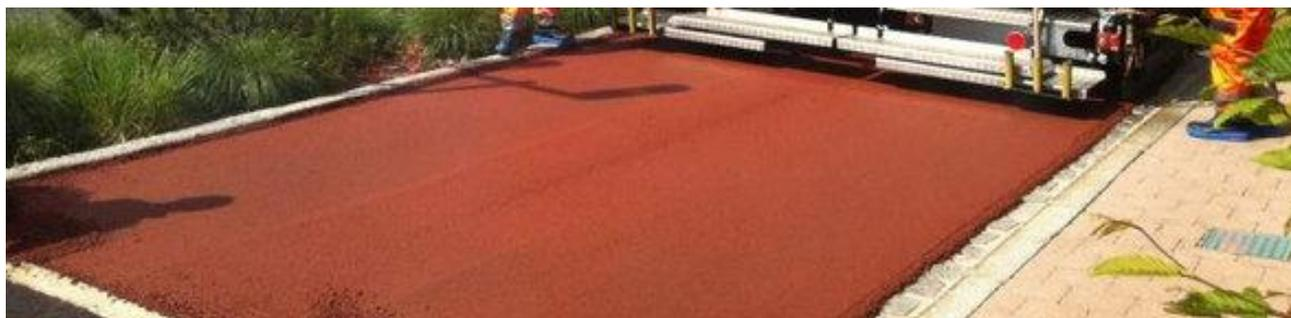
**Abb. 54 Prinzip der Auflegung von Gußasphalt**
