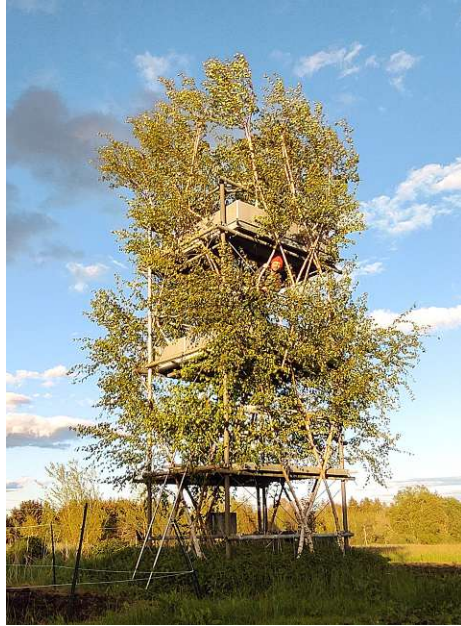
Abb.44: Baubotanischer Turm in Neue Kunst am Ried
