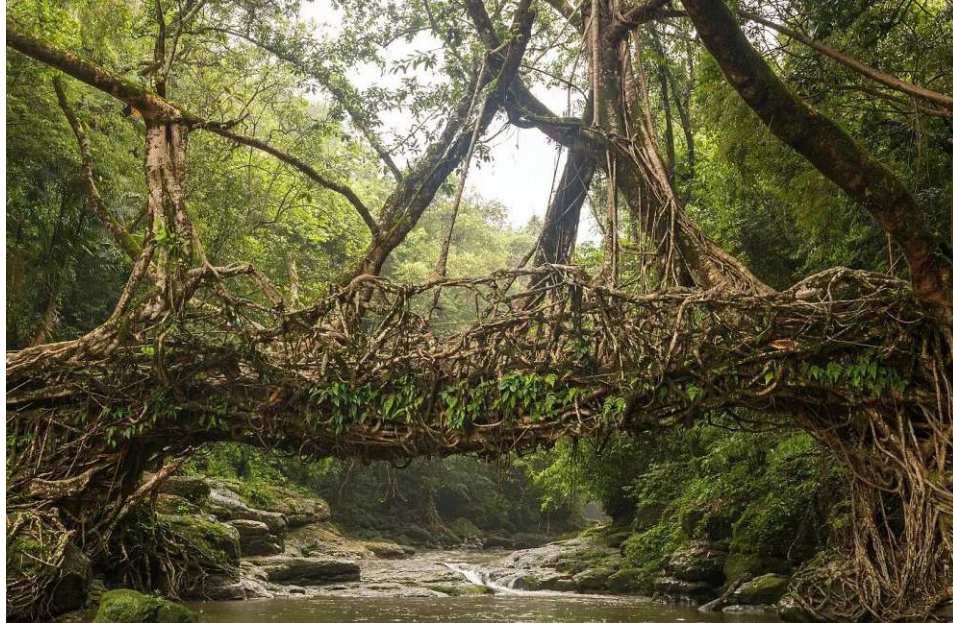
Abb.41.: Lebende Brücke der Khasi in Mawlynnong
