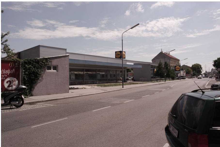
Abbildung 36: Filiale Kaiser-Ebersdorfer-Straße Südansicht
