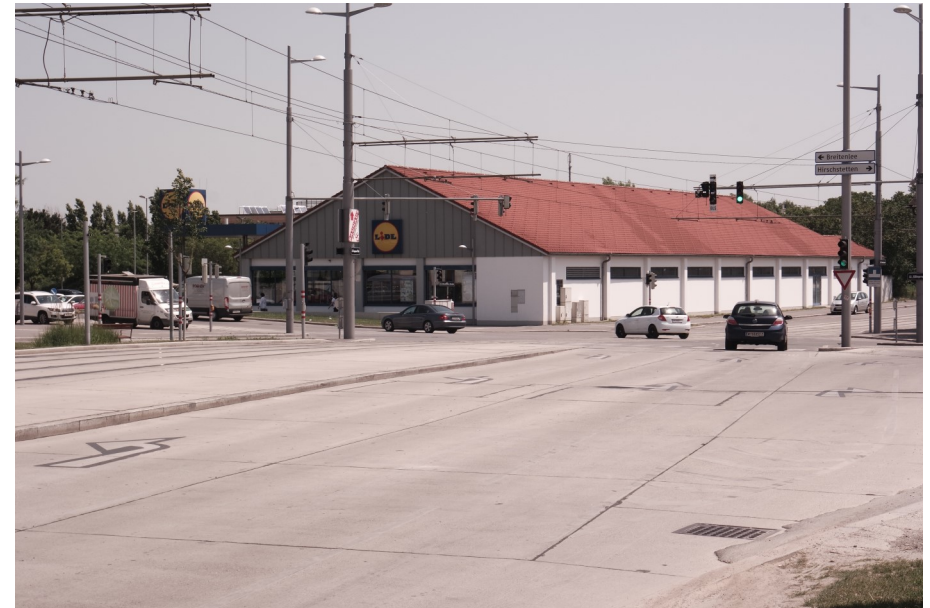
Abbildung 40: Filiale Breitenleerstraße Ostansicht
