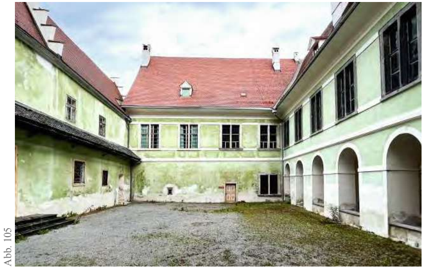
Abb. 104 Propstei Aflenz (eigene Erstellung, 2023) Abb. 105 Propstei Aflenz (eigene Erstellung, 2023)
