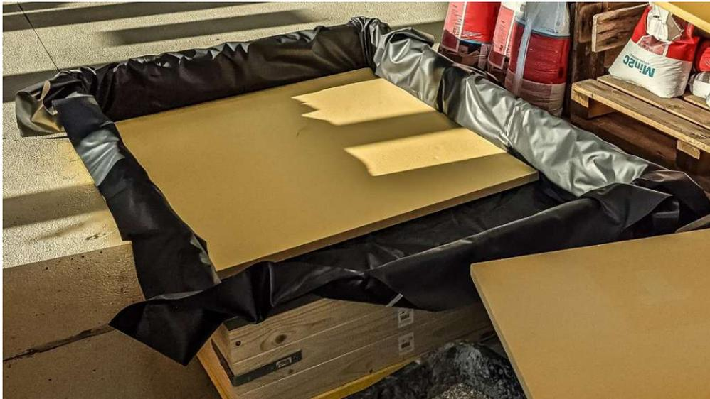
*Abbildung 18: Kiste mit Folie und XPS-Platten ausgelegt*
