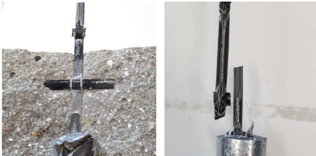
Abb. 8-43: Abscherung im Verbundbereich (links); Bruchstelle beim Einspannrohr (rechts)
