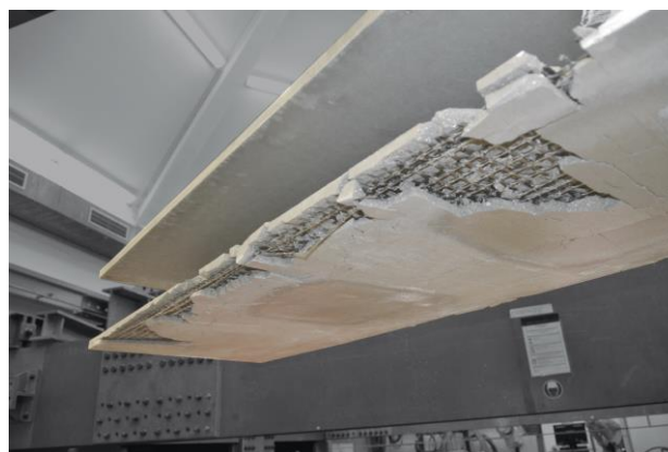
Abb. 3-3: Spaltrissversagen an einem textilbewehrten Träger (Preinstorfer 2019)
