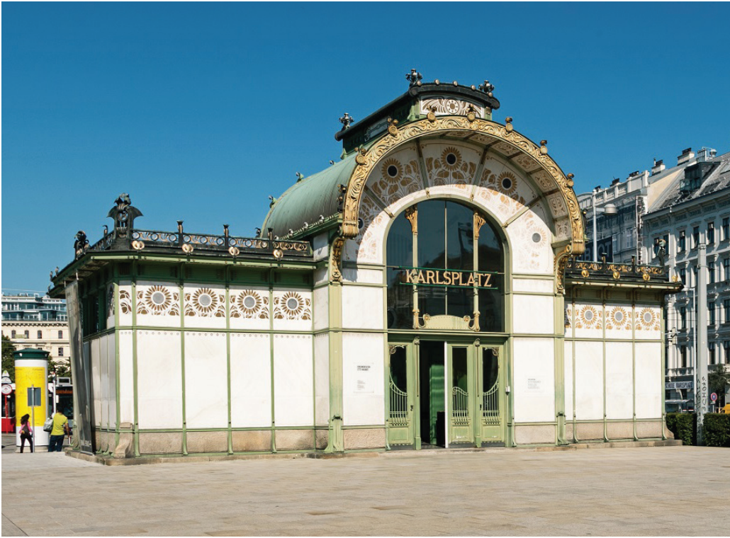
Abb. 13: Otto Wagner, Station Karlsplatz, 1899
