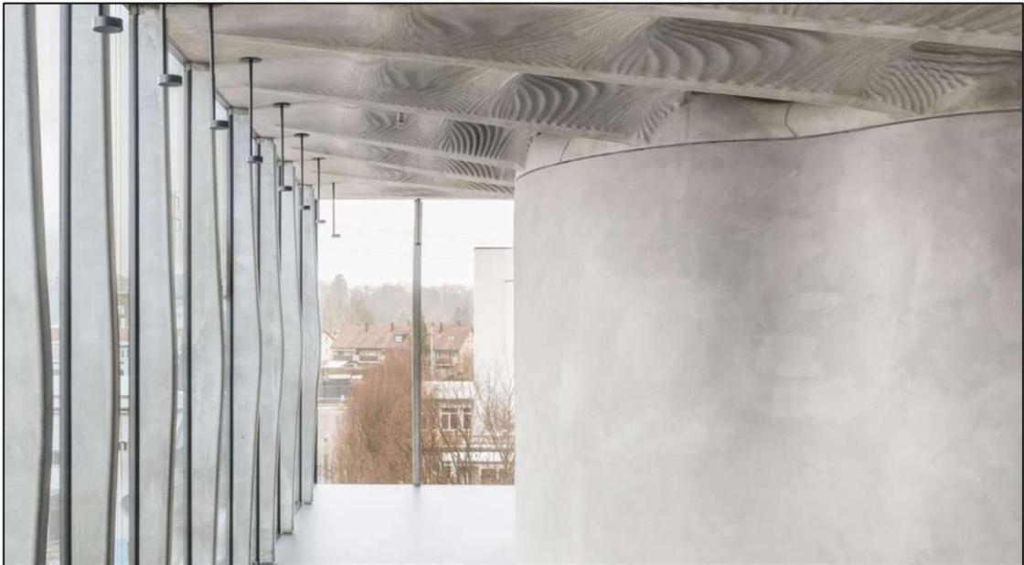
Abbildung 19: Das fertige Bauprojekt mit im „Smart Dynamic Casting“-Verfahren erzeugten Stützpfeiler
