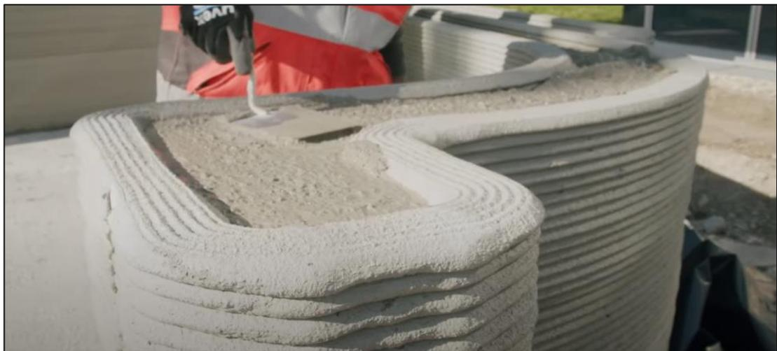
Abbildung 33: Ausfüllen der 3D-gedruckten Wände mit Ortbeton
