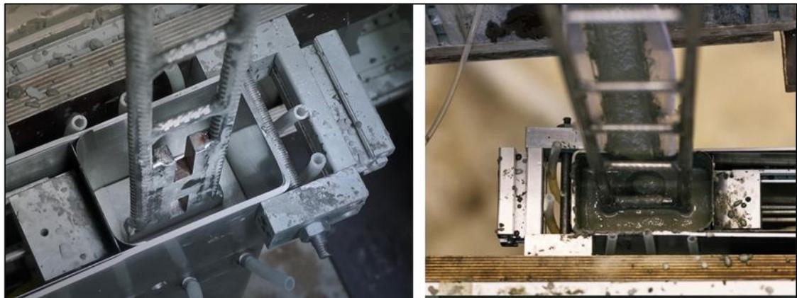
Abbildung 17: „Smart Dynamic Casting“-Verfahren im Detail 1; links: Schalung inklusive der Eisenbewehrung, rechts: Befüllen der Schalung mit der Frischbetonmischung.
