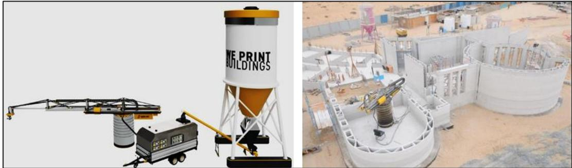
Abbildung 25: Komponenten eines Polar Druckers (links); Ein im Druck befindlicher Polar Drucker (rechts)
