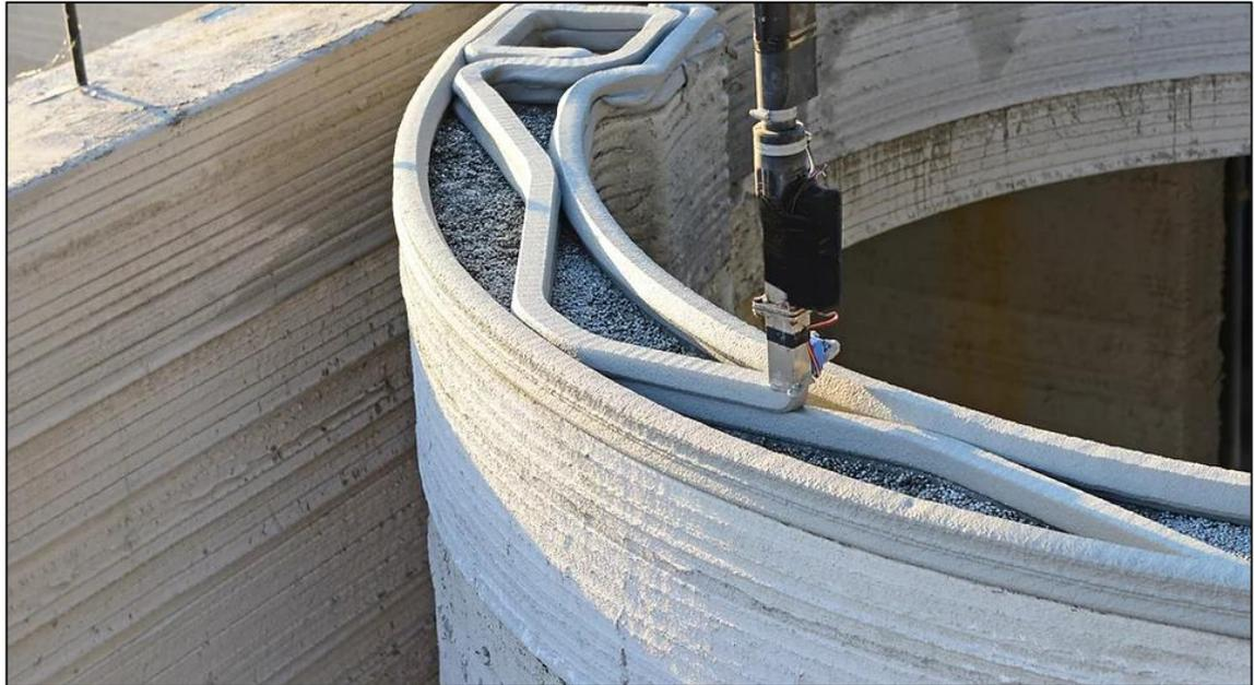
Abbildung 37: Einbringen von Schaumglas in Form von kleinen Kügelchen
