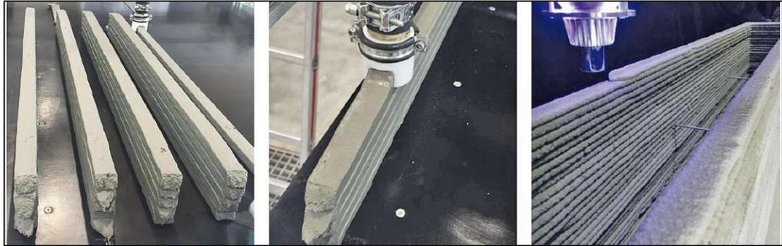
Abbildung 11: Darstellung zeigt Feldversuche einer Mittelfilamentablage
