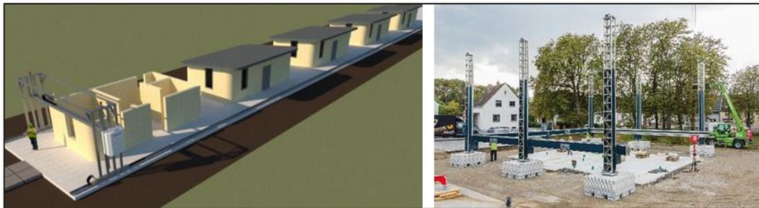
Abbildung 23: Fundament mit Schienensystem für einen Gantry Drucker (links)
