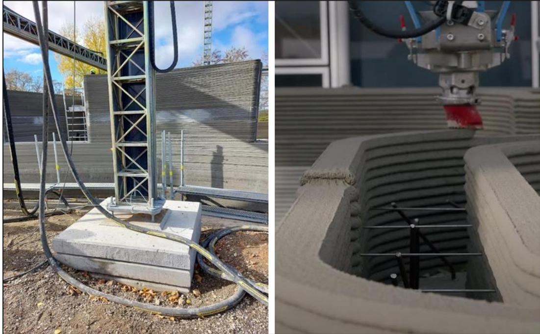
Abbildung 31: Eines von insgesamt sechs Betonfundamenten für den Gantry Drucker (links); Hohlraum zwischen den gedruckten Filamentschichten mit minimaler Bewehrungen und dünne Spangen, die eine vertikale Bewegung verhindern sollen (rechts)
