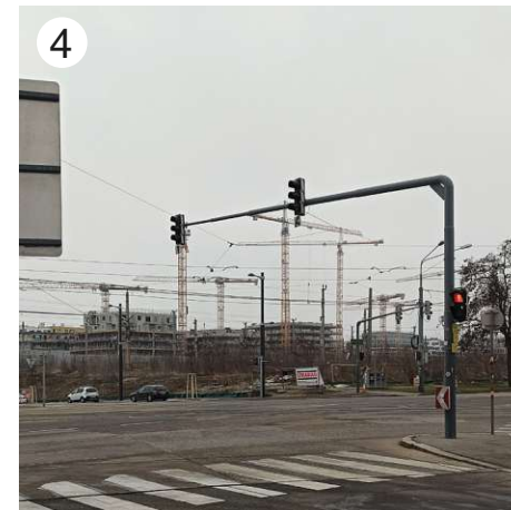
Abb.85: Der Blick auf die Baustelle des Nordbahnhof-Areals.
