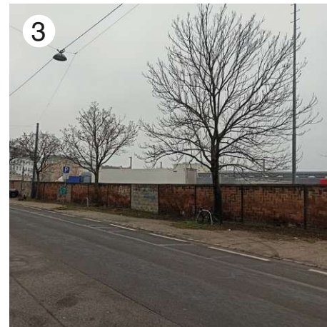
Abb.84: Die das Areal umgebende Mauer.
