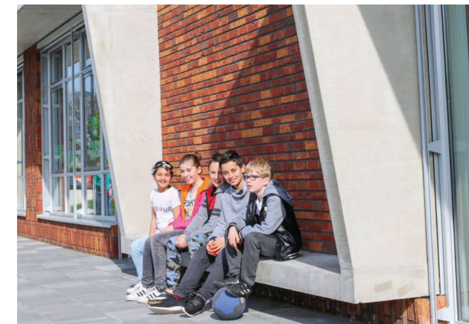
Abb.8: MFA Vlechtwerk: Fassadendetail. Photo: Olivier Architecten.
