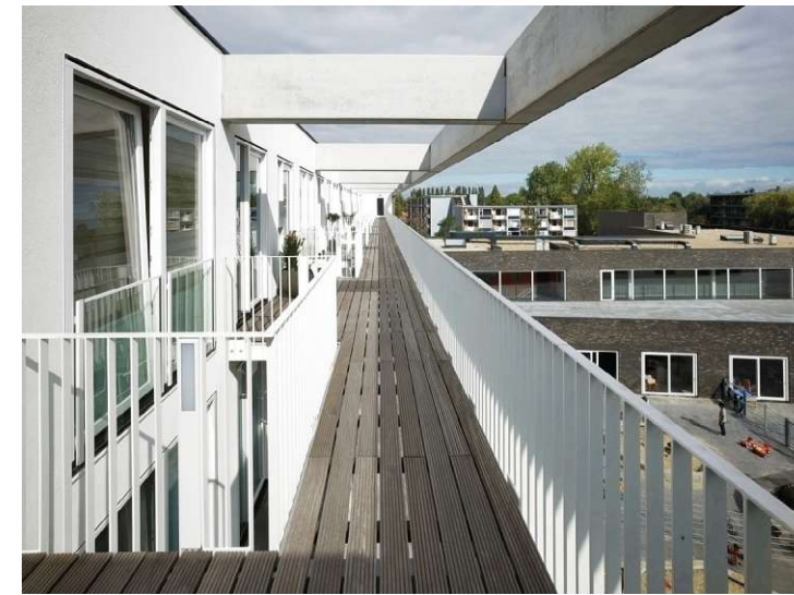
Abb.19: MFA Neslon Mandela Centrum: Balkone von den Wohnugen im 3. Obergeschoss. Photo: ATELIER PRO Architecten.
