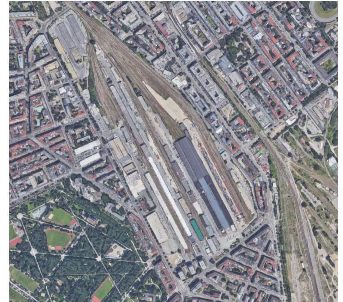
Abb.80: Nordwestbahnhof-Areal: Luftbild. Quelle: Google Maps.
