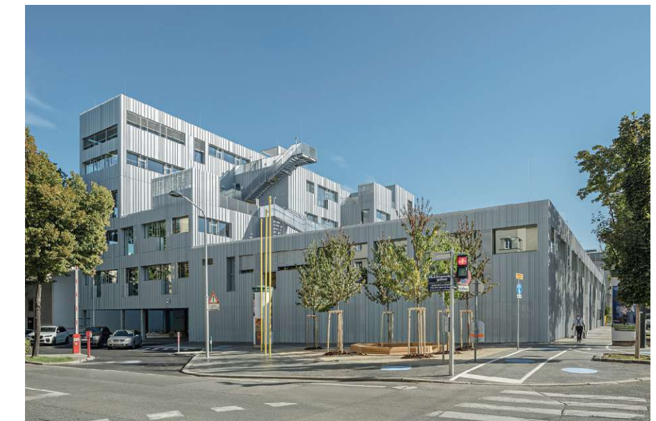
Abb.35: Schule Längenfeldgasse: Außenansicht. Photo: Hertha Hurnaus.
