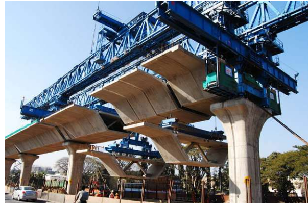
(b) Brückenbau mit vorgefertigten Vollfertigteilstegsegmenten und über dem Tragwerk liegendem Rüstträger, © VSL International: Nelamangala Expressway – Viadukt, Bangalore, Indien
