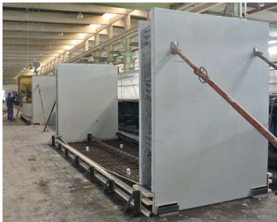
(a) Betonage der Bodenplatte zwischen zwei Stegwänden, entnommen aus [23]
