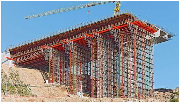
(a) Herstellung eines Spannbetonhohlkastens auf einem Lehrgerüst mit Rüsttürmen aus Stahl, entnommen aus [38], © Peri
