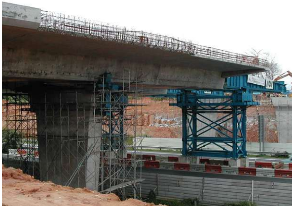
(a) Herstellung eines Spannbetonhohlkastens mit dem Taktschiebeverfahren, entnommen aus [9], © VSL International
