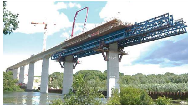
(b) Brückenbau mit Ortbeton auf einer Vorschubrüstung, entnommen aus [9], © Thyssenkrupp Infrastructure, Saul Ingenieure
