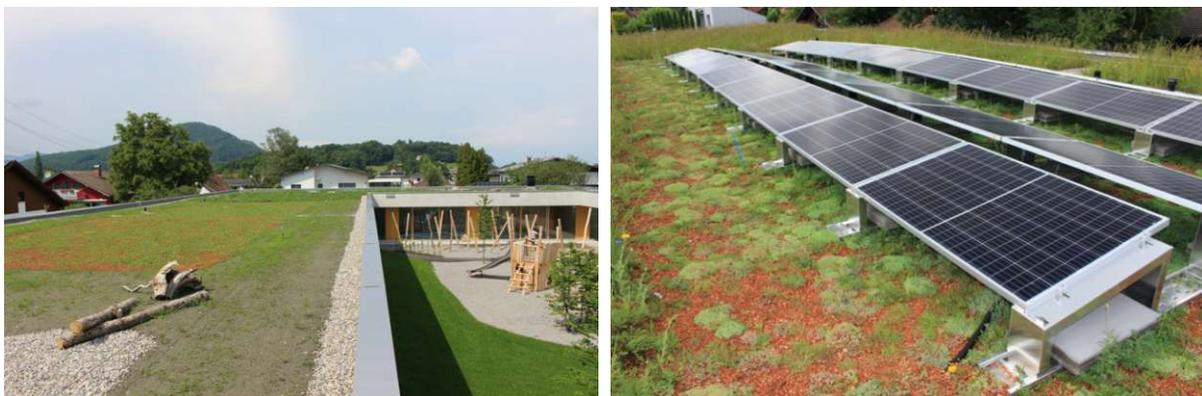
**Abb. 71:** links: Dachfläche Ziegelrecyclingsubstrat © Gemeindeamt Koblach und rechts: PV-Anlagen © Gemeindeamt Koblach
