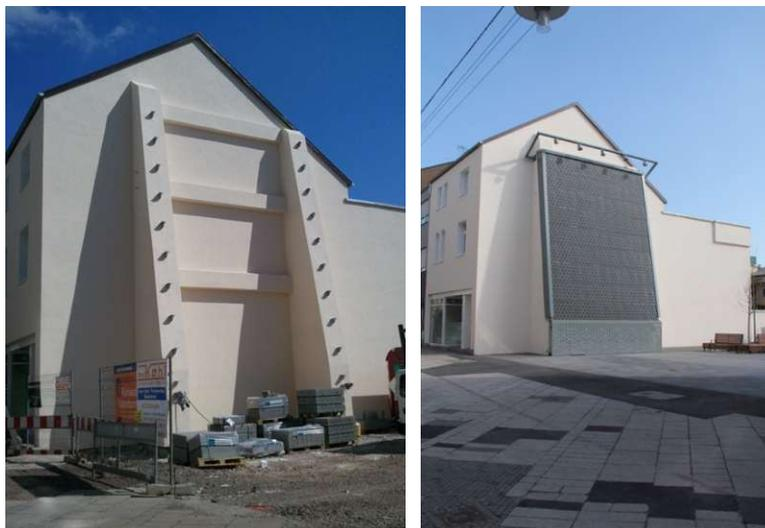
**Abb. 39:** links: Lisenen mit Konsolen © Dutt & Kist GmbH [73] und rechts: Begrünungselemente eingehängt © Dutt & Kist GmbH [73]
