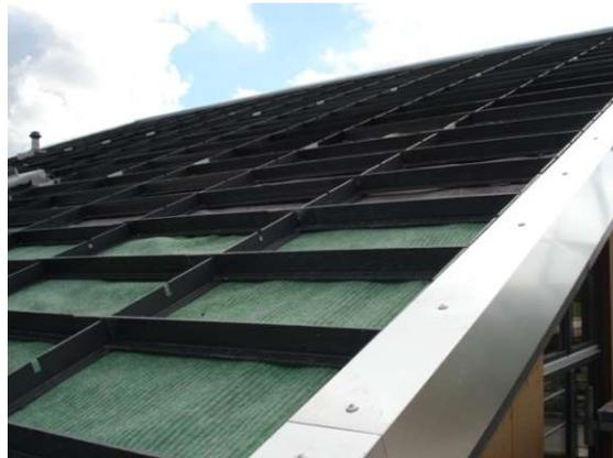
**Abb. 62:** Schubsicherung Schrägdach © Optigrün international AG [100]
