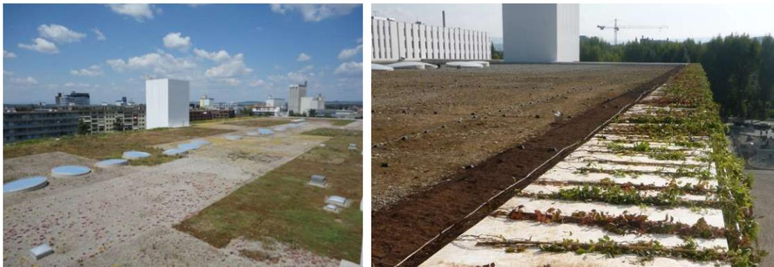
**Abb. 54:** links: Nahaufnahme Dachbegrünung © Fahrni und Breitenfeld GmbH und rechts: Hängepflanzen © Fahrni und Breitenfeld GmbH [26, p. 219]
