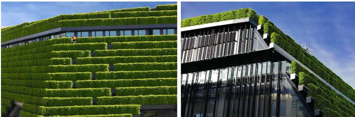
**Abb. 27:** links: Hainbuchen Nahaufnahme © Jakob Leonhards Söhne GmbH & Co. KG [50] und rechts: Auskragung Pflanztröge © Jakob Leonhards Söhne GmbH & Co. KG [50]
