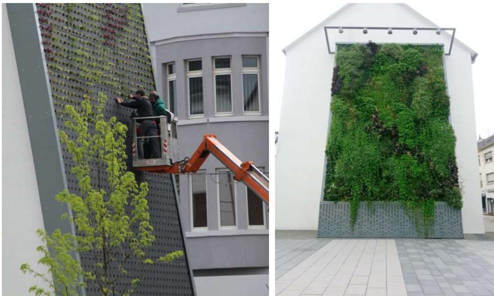
**Abb. 40:** links: Einsetzen der Pflanzen mit Hubsteiger © Dutt & Kist GmbH [73] und rechts: fertige Grünwand © Dutt & Kist GmbH [73]
