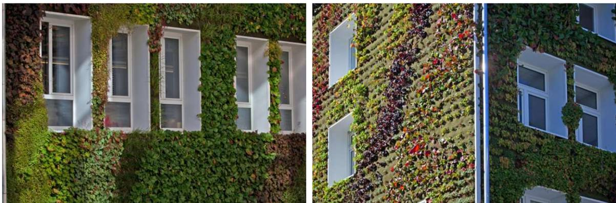
**Abb. 43:** links: Nahaufnahme Pflanzen Living Wall © GDL Belke GmbH, Clemens Belke und rechts: Vlies-Substrat-System © GDL Belke GmbH, Clemens Belke
