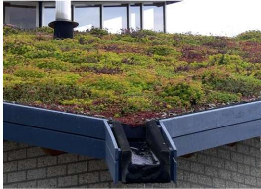
Abb. 10: Extensive Dachbegrünung © Lamiot [18]
