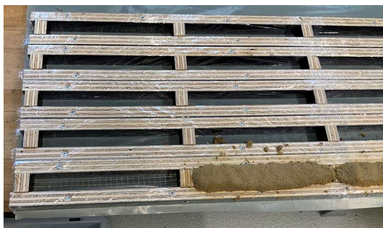
Abb. 4.6: Flachsgewebe in Schalung, mit und ohne Lehm-masse
