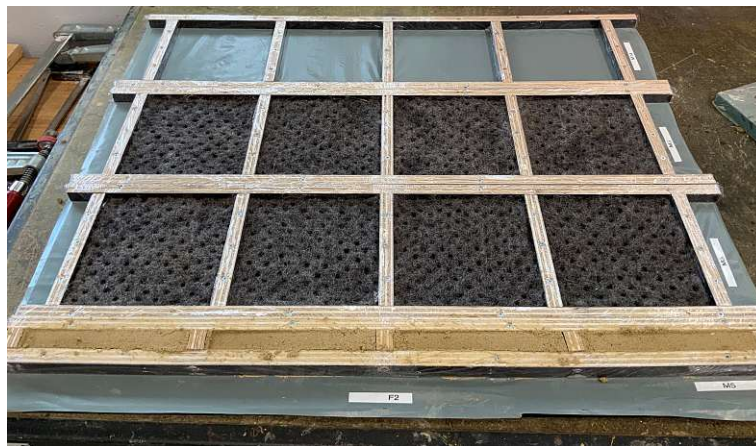
Abb. 4.2: Hinten: Filz in Schalung eingelegt, vorne: Lehm bereits eingefüllt
