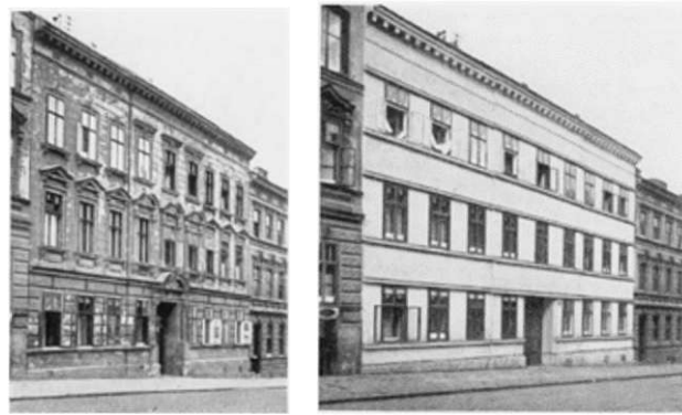
Abb. 3.7: Ganglbauergasse 29, vor und nach Durchführung der geförderten Fassadenumgestaltung Quelle: Knauer (2022:11)
