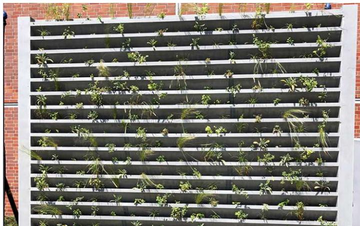
**Abb. 3.6:** Betonfertigteile zur Fassadenbegrünung des IAB Weimar direkt nach der Bepflanzung (Bildquelle: Institut für Angewandte Bauforschung Weimar gGmbH [84])
