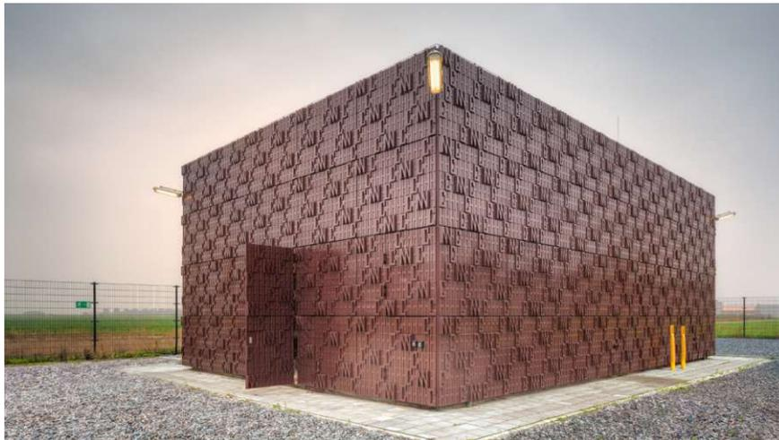
**Abb. 4.16:** Fassadenverkleidung einer Gasempfangsstation, in Dinteloor, Niederlande mit einem *Nabasco*-Material der Firma NPSP (Bildquelle: Studio Marco Vermeulen [176])
