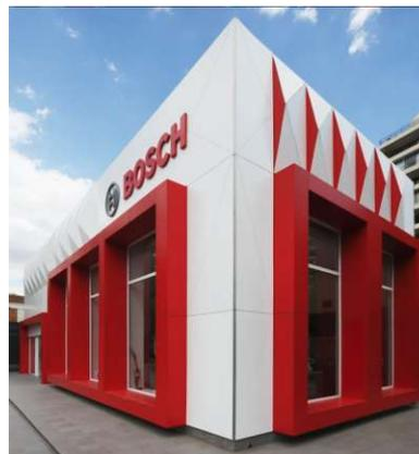
**Abb. 4.19:** Fassadenverkleidung des Bosch-Hauses Chile mit *Tricoya*<sup>®</sup>-Platten vom chilenischen Hersteller Masisa (Bildquelle: Accsys Technologies PLC [7])
