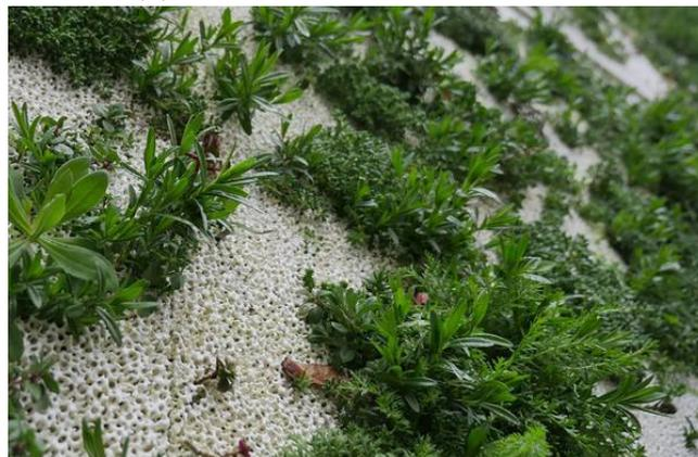
(b) Detailaufnahme Außenfassade *Skyflor*<sup>®</sup> mit sichtbarer Keramikoberfläche
