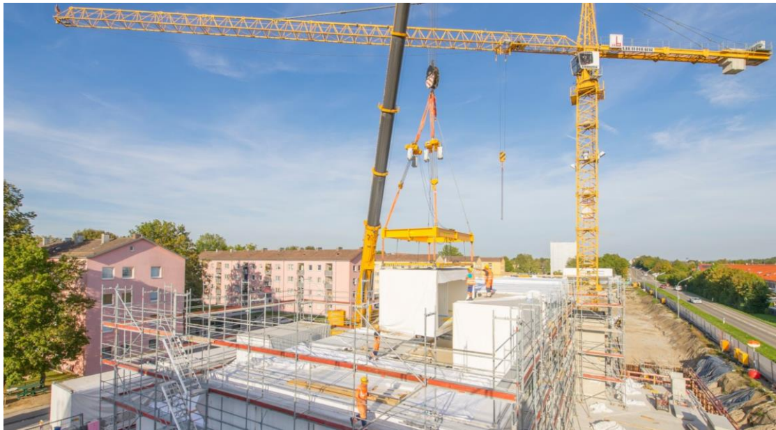
Abb. 45: Verheben der Elemente auf der Baustelle – Max Modul ( https://www.maxmodul.de/maxmodul/gesamtprozess )
