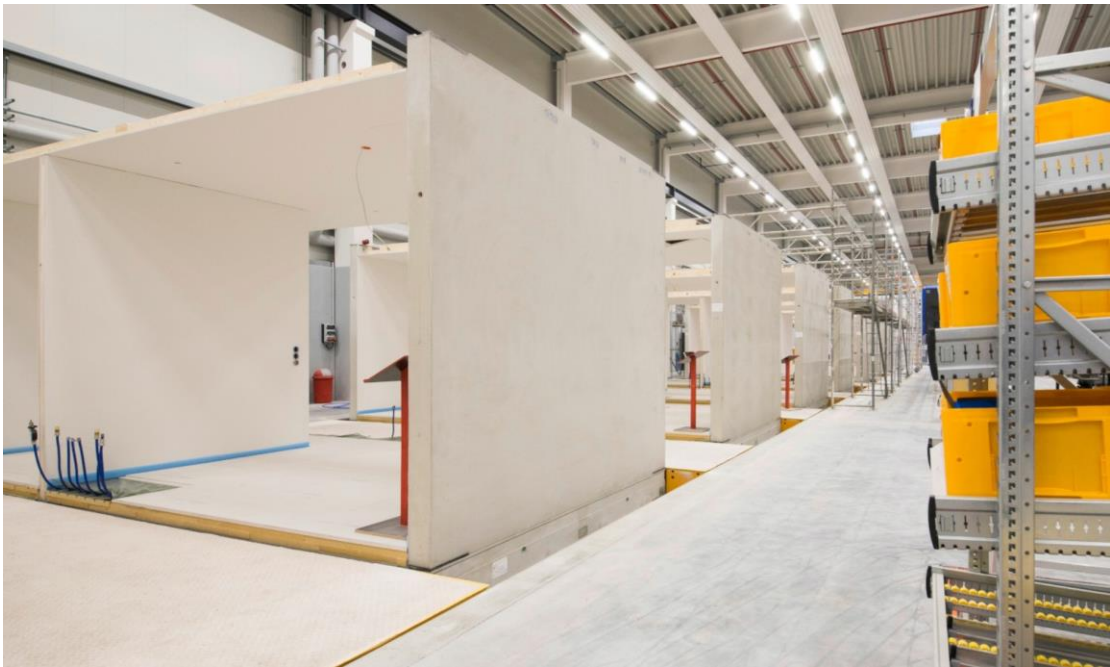
Abb. 44: Blick in die Montagehalle von Max Modul ( https://www.maxmodul.de/maxmodul/gesamtprozess )
