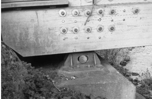
Abbildung 3-26 – Loslager der Holzbrücke (eigene Aufnahme)
