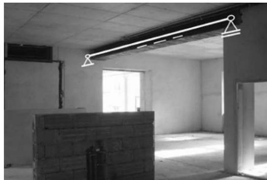
Abbildung 3-12 – Balken: Interpretation des statischen (analytischen) Modells ist mit weißer Linie dargestellt (Pech et al. 2018, S. 16)
