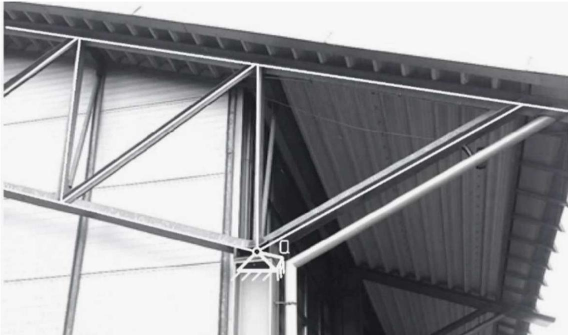
Abbildung 3-25 – Festlager des Stahlfachwerks (eigene Aufnahme)
