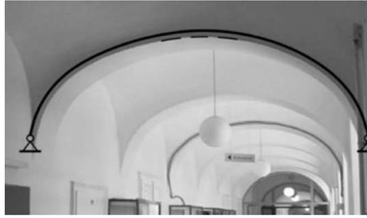
Abbildung 3-14 – Bogen: Interpretation des statischen (analytischen) Modells ist mit schwarzer Linie dargestellt (Pech et al. 2018, S. 17)
