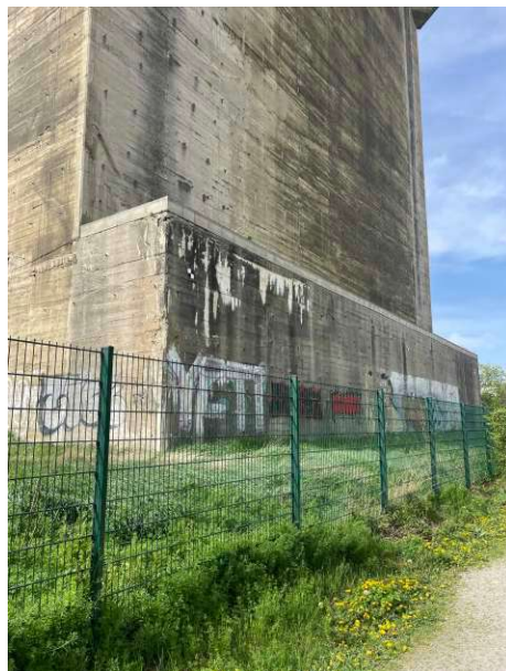
Abb 116: Eingangstreppen, Eingangstür zugemauert bzw. mit Stahl verschlossen
