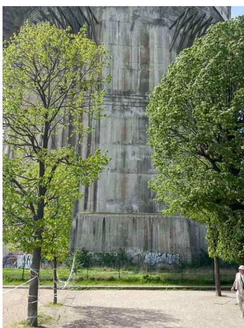
Abb 155: Eingang Gefechtsturm vermutlich nie gebaut Abb 156: Eingang Gefechtsturm, zugemauert oder mit Stahltür verschlossen (2024)
