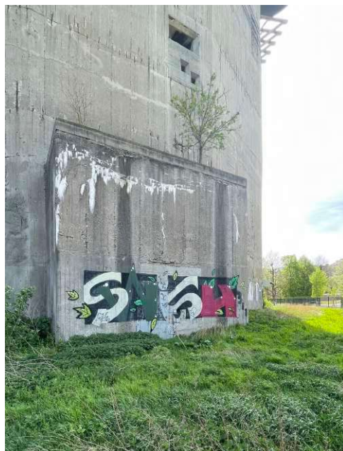
Abb 153/ Abb 154: Eingänge Gefechtsturm, zugemauert oder mit Stahltür verschlossen (2024)
