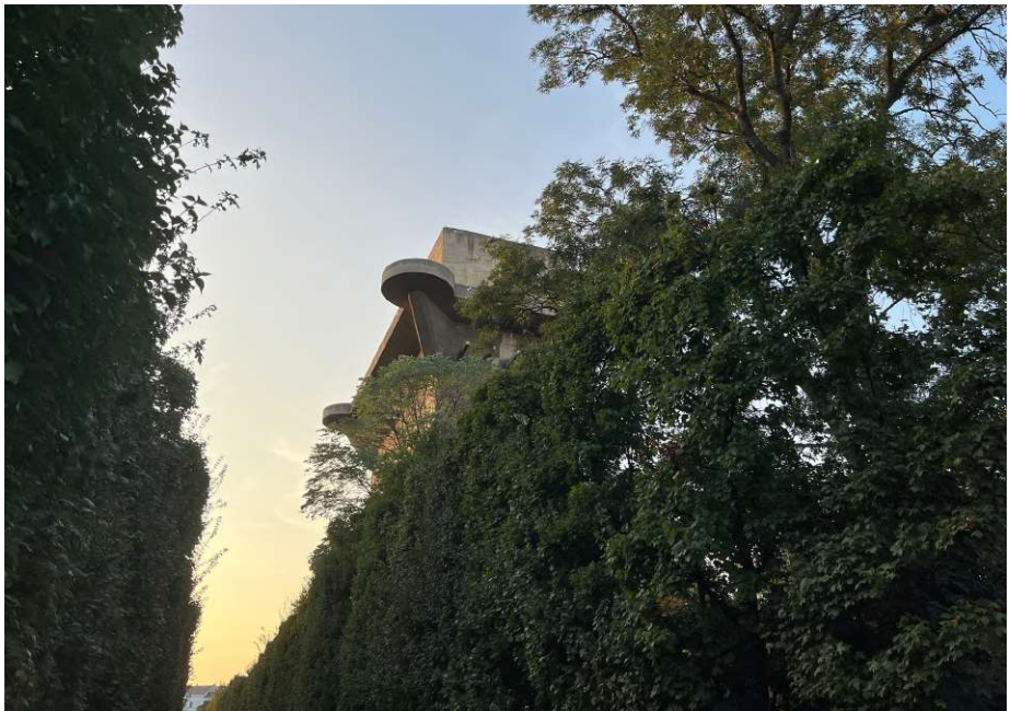
Abb 120: Südseite Leitturm / Abb 121: Obere Plattform Leitturm (2024)
