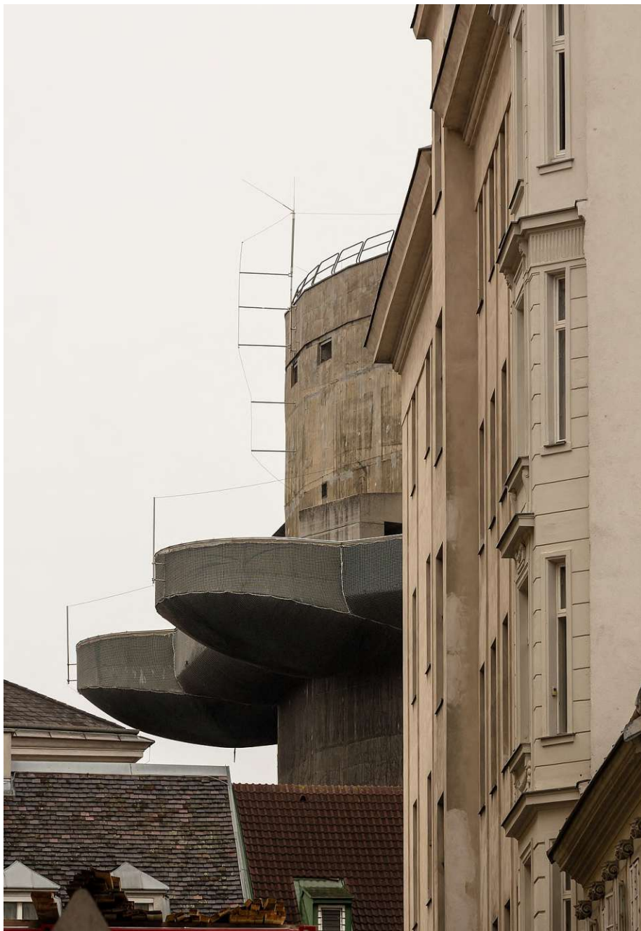
Abb 29: Ehemaliger Gefechtsturm in der Stiftskaserne.
