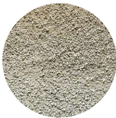
Bodenbelag im Gang Brechsand: 0/3mm
