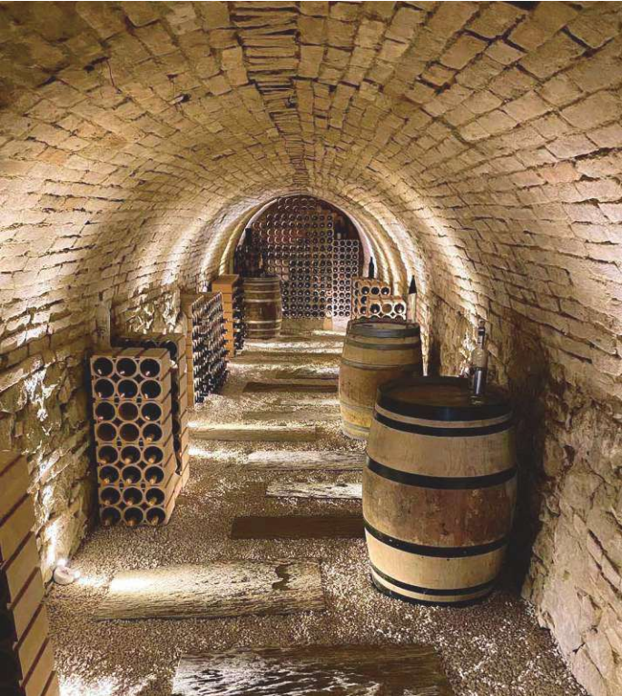
Abb.159 Kellerröhre 2024, nach Sanierung
