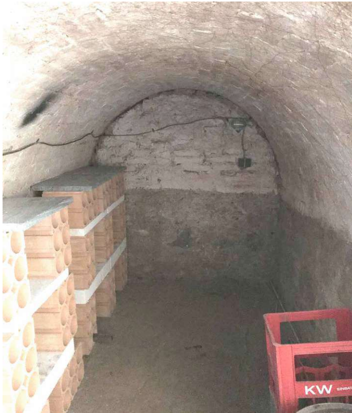
Abb.156 Kellernische 2020, vor Sanierung
