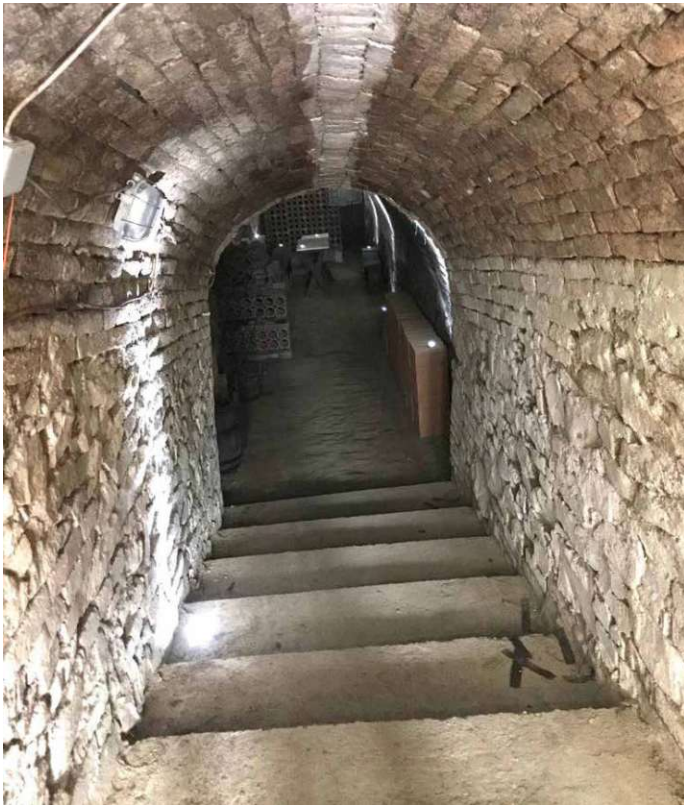
Abb.154 Kellerhals 2020, vor Sanierung
