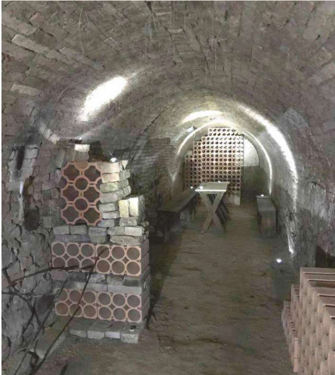
Abb.158 Kellerröhre 2020, vor Sanierung
