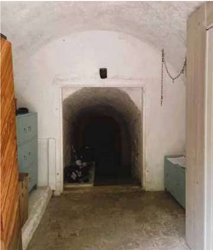
Abb.153 Vorhaus Weinkeller 2024, nach Sanierung
