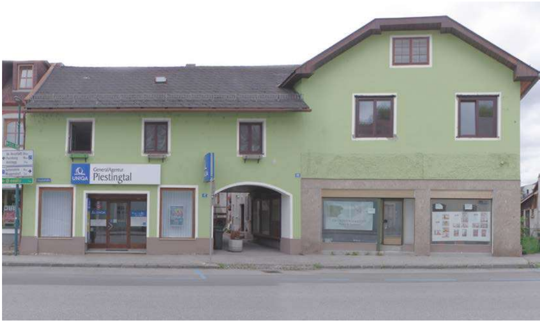
Fotografie der bestehenden Fassade
