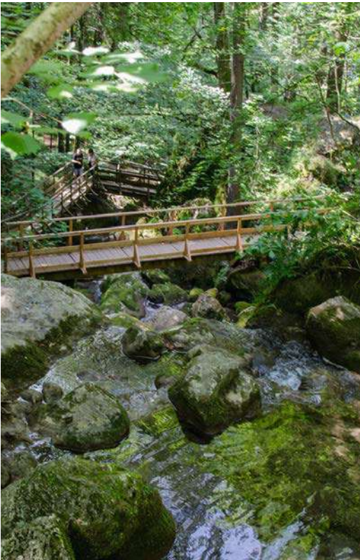
Abb. 34: Brücken über den Myrabach
