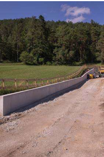
Abb. 45: Ein Aushub in der Gorgastraße Pernitz
