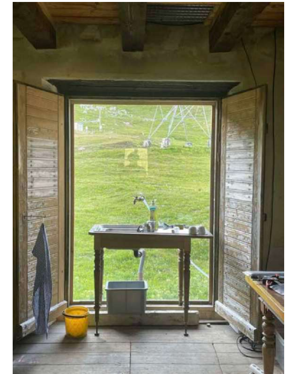
Abb20.: Waschbecken Installation als einer der Eingriffe
