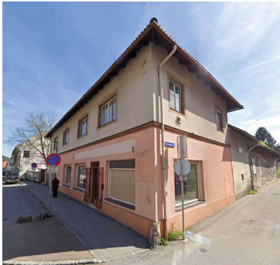
Abb32.: Fotografie der bestehenden Fassade
