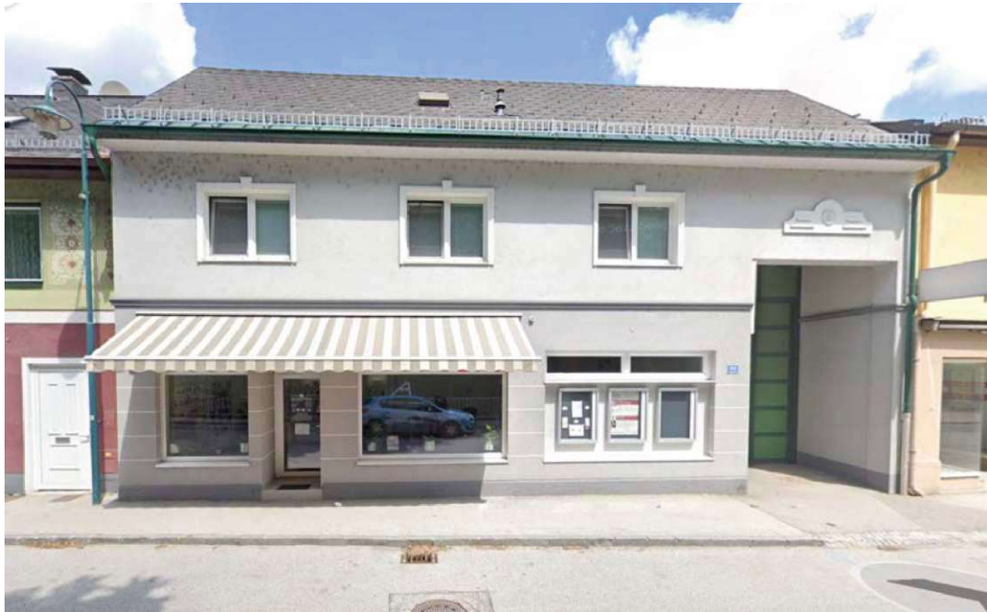
Abb23.: Fotografie der bestehenden Fassade
