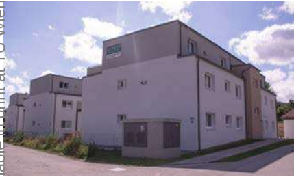
Abb. 12: Genossenschaftswohnbau in Pernitz
