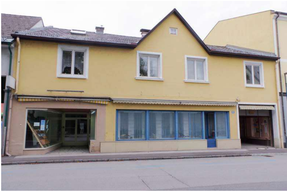
Fotografie der bestehenden Fassade
