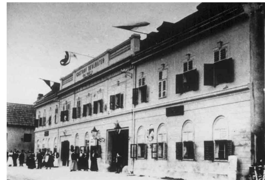
Abb28.: historisches Foto zeigt das die Passage einmal schon existiert hat
