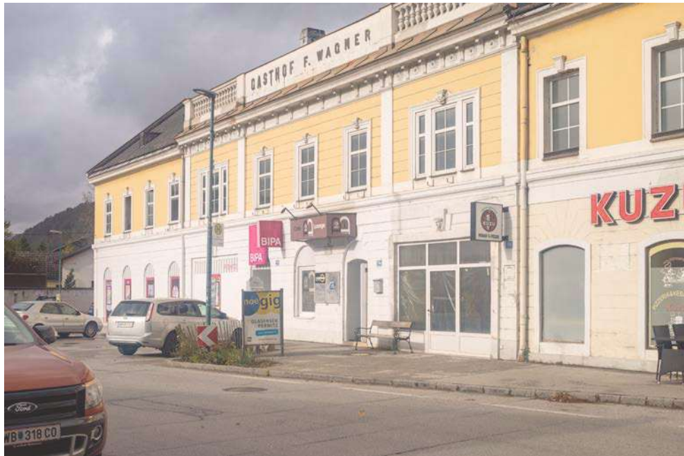
Fotografie der bestehenden Fassade
