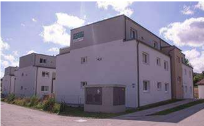
Abb. 12: Genossenschaftswohnbau in Pernitz
