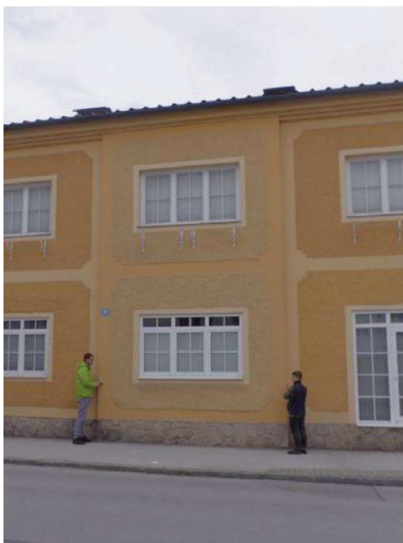
Abb. o6: Bestandsaufnahme an der Hauptstraße
