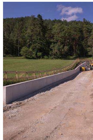
Abb. 45: Ein Aushub in der Gorgastraße Pernitz
