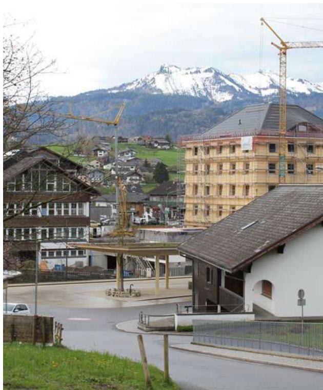
Abb. 34 Der Busbahnhof, seit 2022 fertiggestellt Foto: Amanda Immler, 04.04.2024
