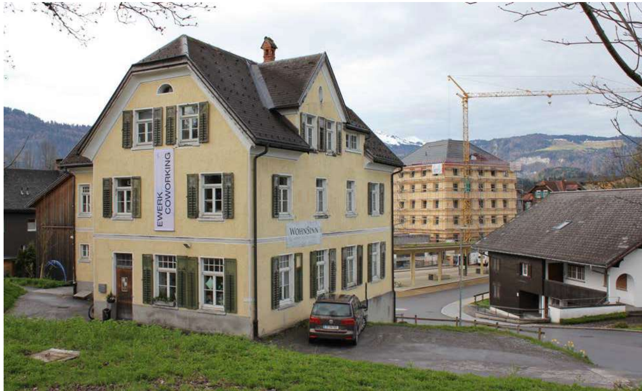
Abb. 32 Ehemalige Elektrizitätswerk („E-Werk“) Foto: Amanda Immler, 04.04.2024
