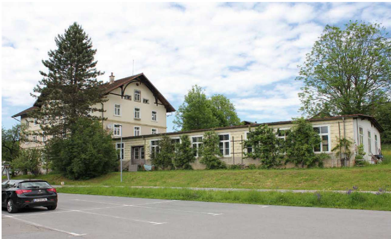
Abb. 124 Die "Isenbergfabrik", erbaut Anfang des 20. Jahrhunderts, heute großteils als Lager genutzt Foto: Amanda Immler, 21.05.2024
