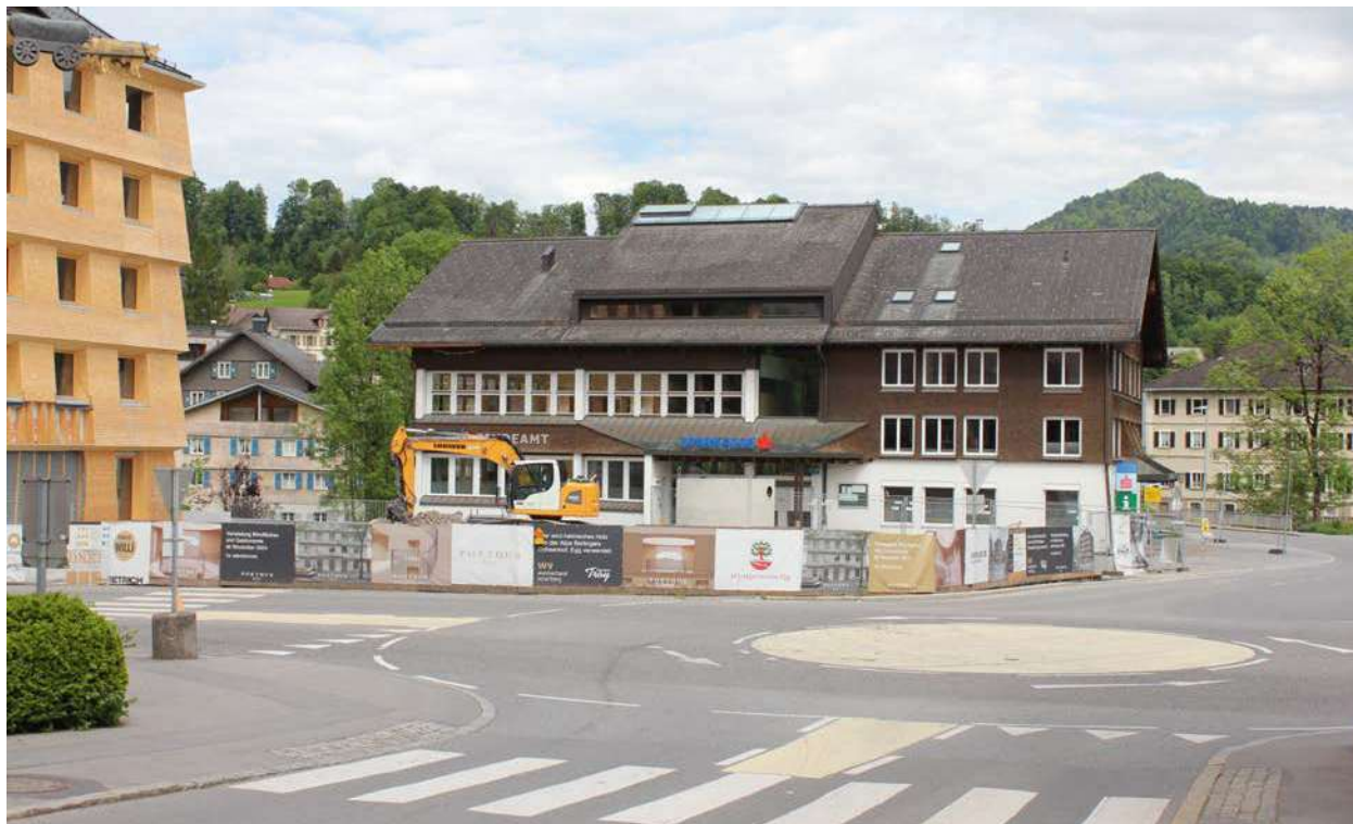
Abb. 70 Gemeindeamt und Gemeindeplatz - aktuell ist hier Baustelle Foto: Amanda Immler, Mai 2024
