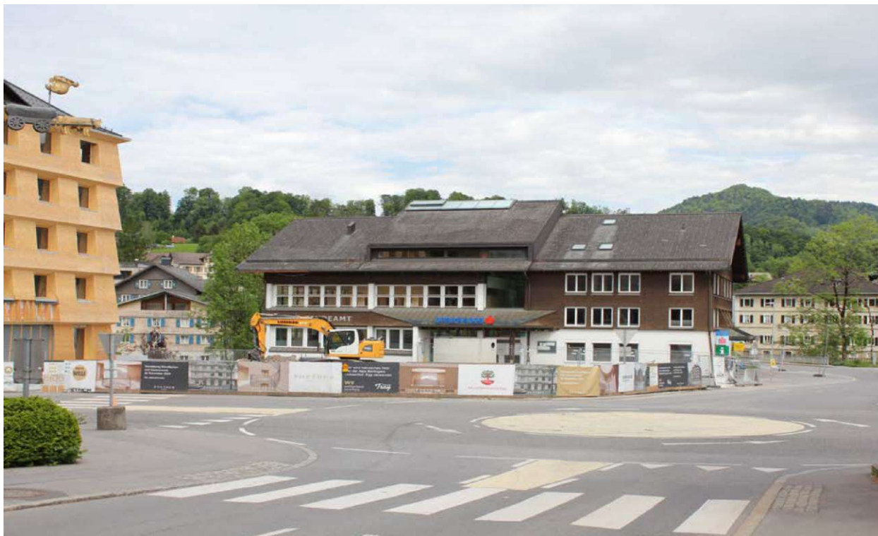
Abb. 157 Umbauarbeiten am Gemeindeplatz Foto: Amanda Immler, 21.05.2024
