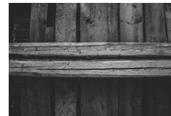
Abb. 129: Querträger mit darüberliegender Bretterlage, die als Heuboden dient
