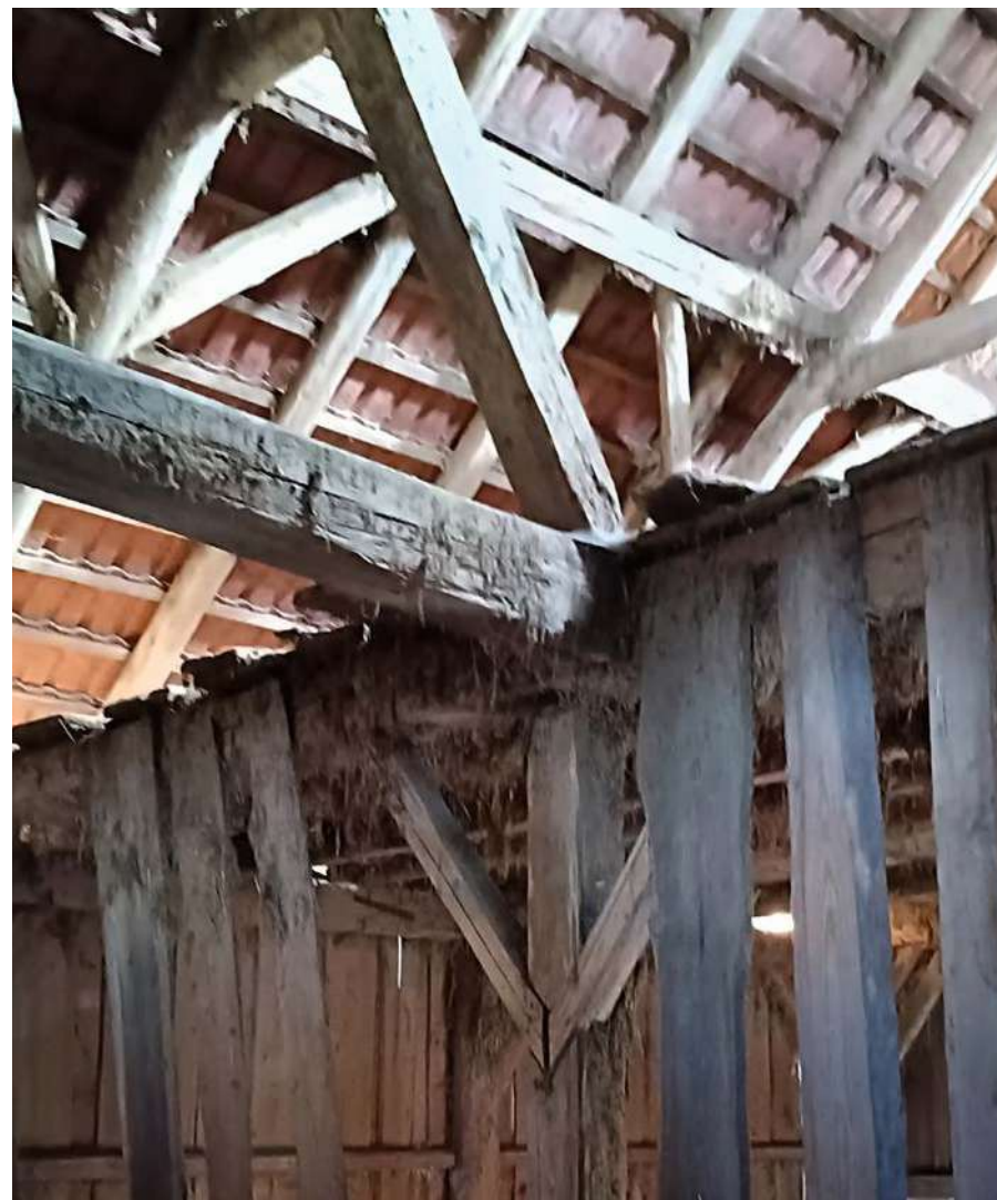
Abbildung 74: Holztragwerk-Knoten, eigene Aufnahme
