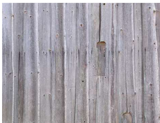
Abbildung 112: Bestandsfassade, eigene Aufnahme
