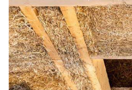
Abb. 24: Stroh in Holzständerwand (C.A.R.M.E.N eV, 2020) 32
