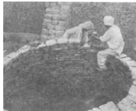
Brice, Dönmez, Bau einer Kuppel in Harran, 1947, bei Kuppelbau positioniert sich der Baumeister auf der Mauerkrone um die Kuppel abzuschließen.
