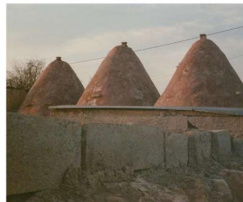
Die Mauer kann aus Stein, Ziegel oder Lehm bestehen und hat in der Regel eine solide, einfache Struktur. In diesem Beispiel sind die Wände, die die roten Kumbet-Häuser von der Straße trennen, aus Betonblöcken gefertigt.
