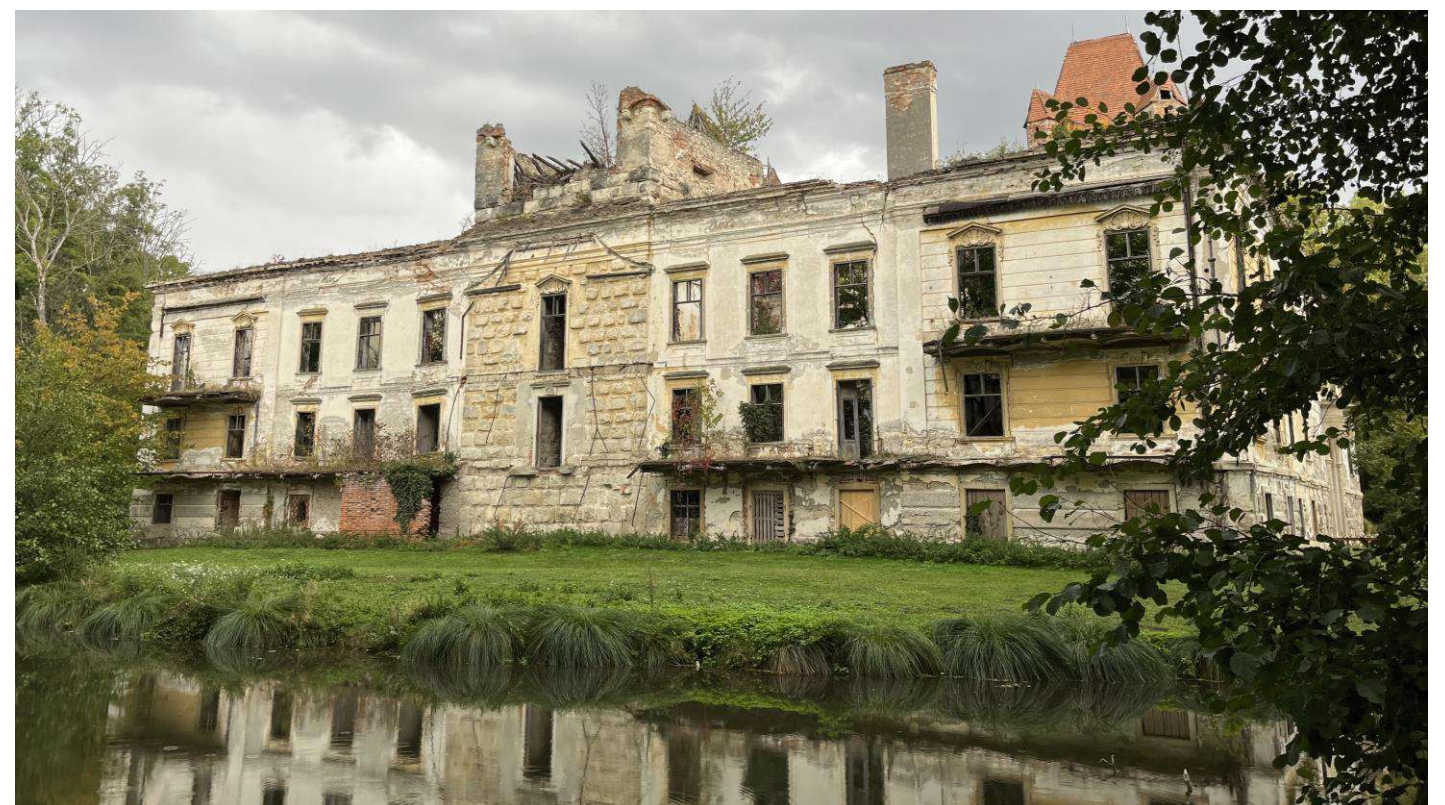
Abbildung 31: Nord-West Fassade, Schloss Pottendorf (Quelle: Eigenes Foto, 2023)
