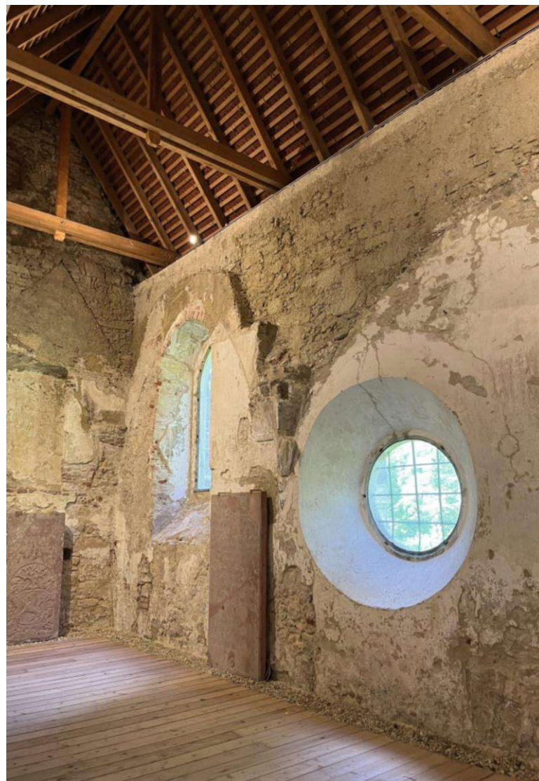
Abbildung 23: Schlosskapelle – Rundfenster im Seitenschiff (Quelle: Eigenes Foto, 2024)
