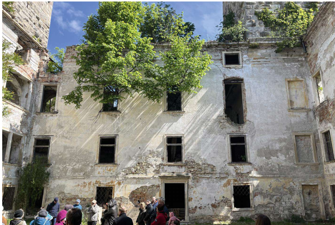
Abbildung 38: Innenhof - Süd-Ost Fassade, Schloss Pottendorf (Quelle: Eigenes Foto, 2024)
