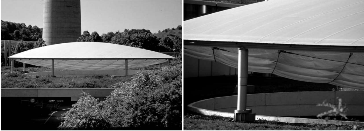
Abb. 3.8: Erhöhung der lokalen Krümmung durch Bespannung mit einem Seilnetz
