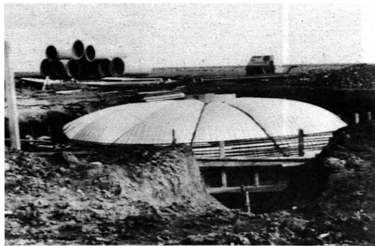
(b) Aufgeblasene Schalungsmembran mit Sicken erzeugenden Seilen, Sobek [17]
