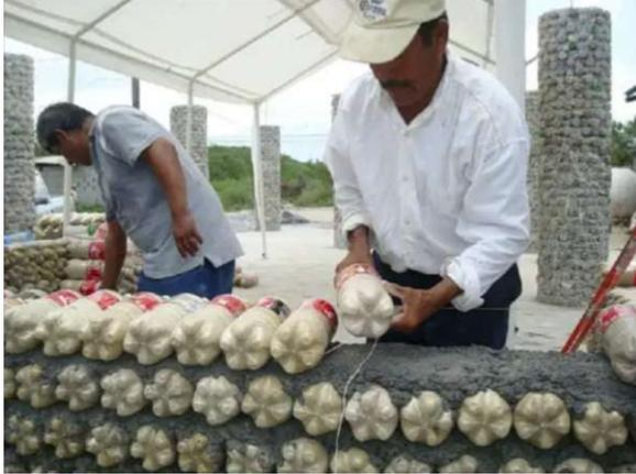
Abb. 5: Arbeiter bauen eine Wand aus PET-Flaschen, Sand und Mörtel
