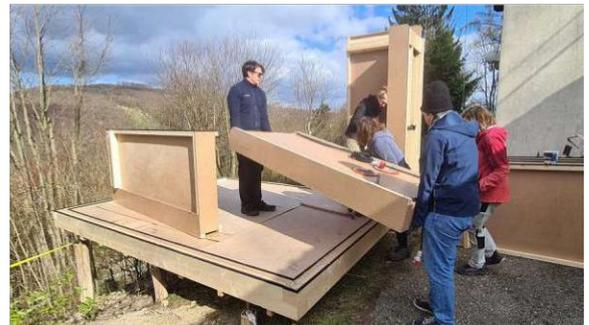
Abb. 143: Montage der weiteren Wandmodule
