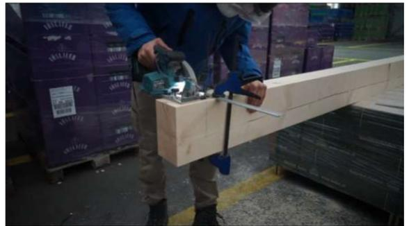
Abb. 74: Zuschnitt des Bodenrahmens
