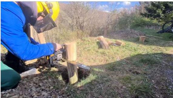
Abb. 136: Kürzen der eingesetzten Fundamentpfähle auf benötigte Höhe
