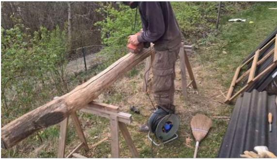
Abb. 132: Aufbereitung der Fundamentpfähle
