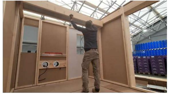
Abb. 104: Einbau der Speicherdeckenmodule
