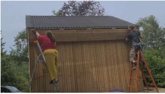
Abb. 179: Montage der rechten Traufenverkleidung
