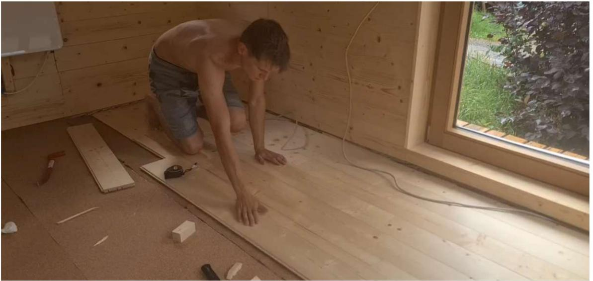
Abb. 196: erstes Fußbodenmodul verlegen
