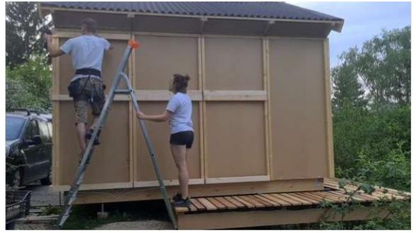
Abb. 172: Montage der Querlattung für die Fassadenmodule
