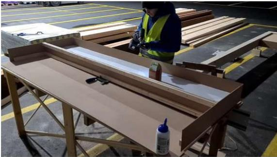
Abb. 79: Zusammenbauen eines Bodenmoduls
