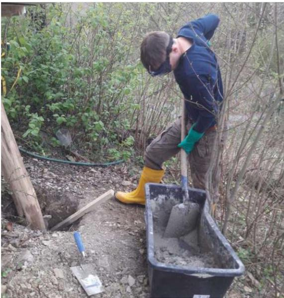
Abb. 161: Anmischen des Betons
