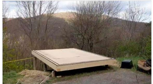
Abb. 141: eingesetzte Bodenmodule
