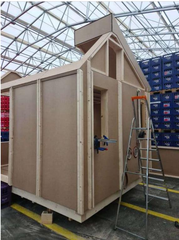
Abb. 113: Montage des ersten Dachmoduls
