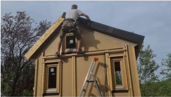
Abb. 159: Montage der Ortgangdeckung
