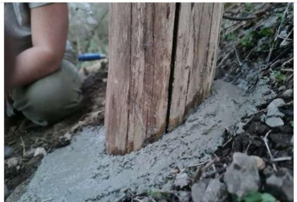
Abb. 162: Betoneinfassung rund um die Fundamentpfähle, um diese zu fixieren
