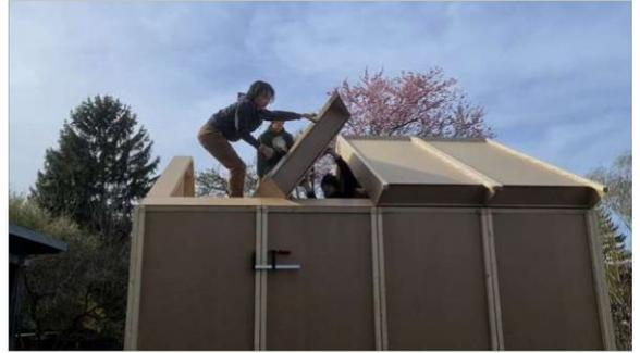
Abb. 149: Montage weiterer Dachmodule
