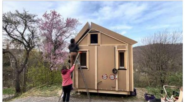
Abb. 151: Montage des letzten Dachmoduls
