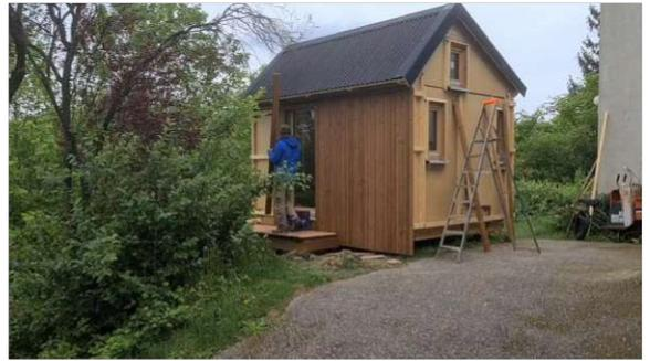
Abb. 174: Montage der Fassade
