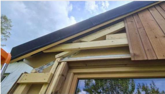
Abb. 175: Unterkonstruktion der Fassadenmodule
