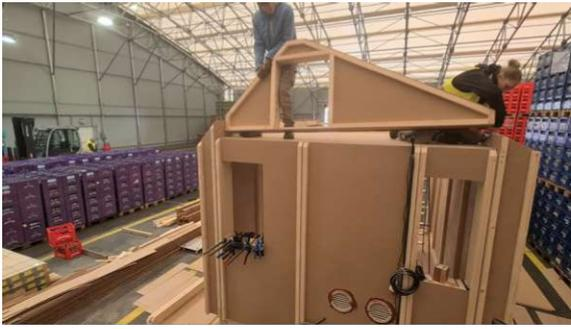
Abb. 111: Montage des hinteren Giebelmoduls
