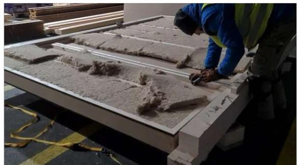
Abb. 84: Verschrauben der Bodenmodule untereinander
