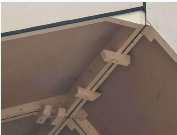
Abb. 115: Montagehilfen für die Dachmontage
