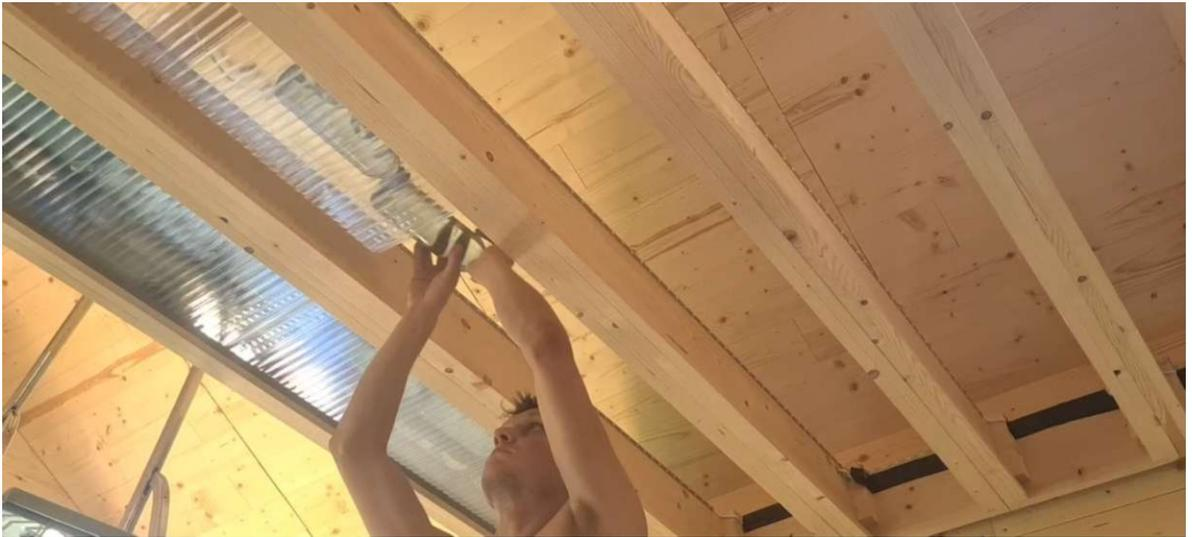
Abb. 193: Befüllen der Speicherdecke mit gefüllten Vöslauer Mehrweg PET-Flaschen
