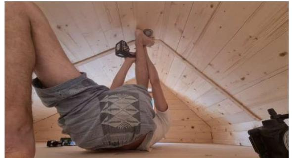
Abb. 206: Montage der Blendleisten
