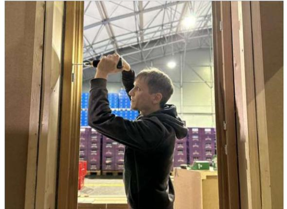
Abb. 106: Einbau der Fenster von WKFenster
