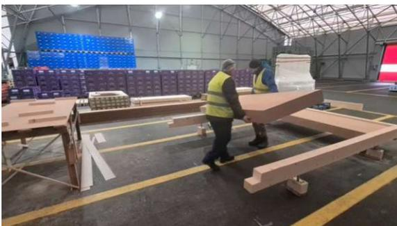
Abb. 83: Einbau der Bodenmodule in den Bodenrahmen
