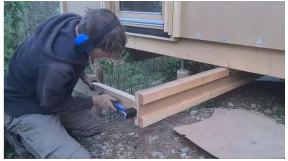
Abb. 164: Unterkonstruktion für den umlaufenden Steg
