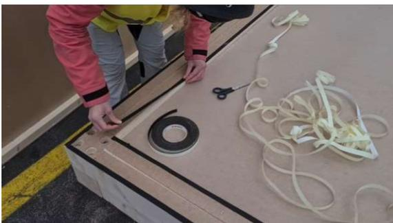
Abb. 91: Aufbringen der Dichtungen unter den Wandmodulen
