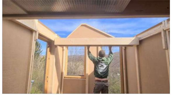
Abb. 147: Verschieben der Speicherdecke Arbeitsplattform
