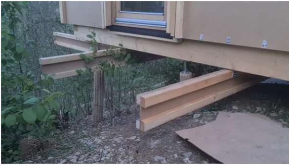
Abb. 163: abgehängte I-Träger mit Stegen aus Hartfaser als Unterkonstruktion für den umlaufenden Steg
