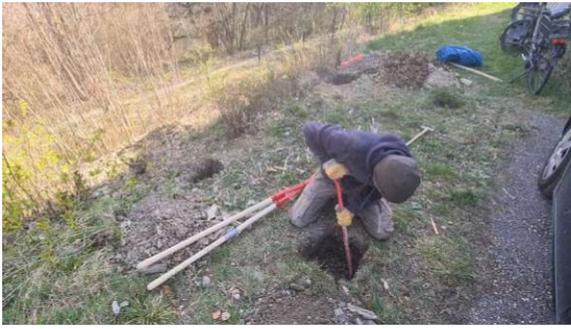
Abb. 130: Graben der Fundamente
