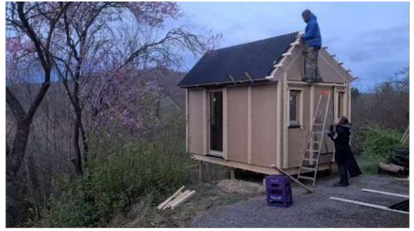
Abb. 156: Montage der Dachdeckung
