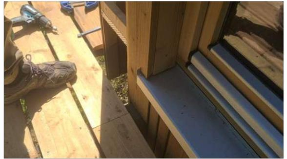
Abb. 176: Einpassung der Fassadenbretter
