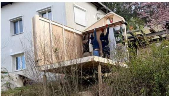
Abb. 144: Montage des ersten Giebelmoduls
