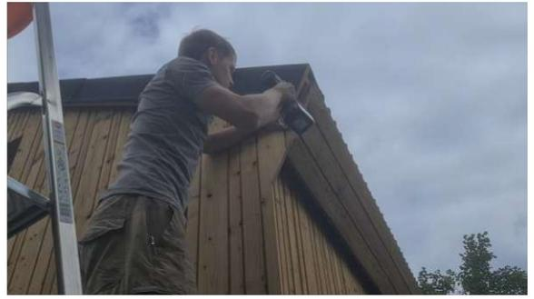
Abb. 180: Anpassung der Fassade an die Traufe
