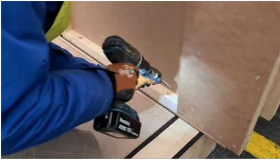
Abb. 93: Verschrauben des ersten Eck-Wandmoduls mit dem Bodenrahmen
