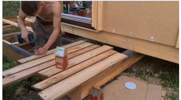
Abb. 166: Montage der wiederaufbereiteten Bretter
