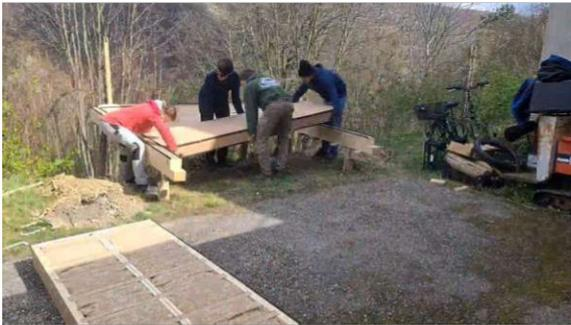
Abb. 140: Einsetzen der Bodenmodule
