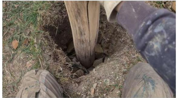
Abb. 135: Drainage aus gesäubertem Aushubmaterial
