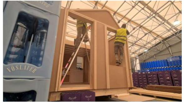
Abb. 112: Montage des vorderen Giebelmoduls
