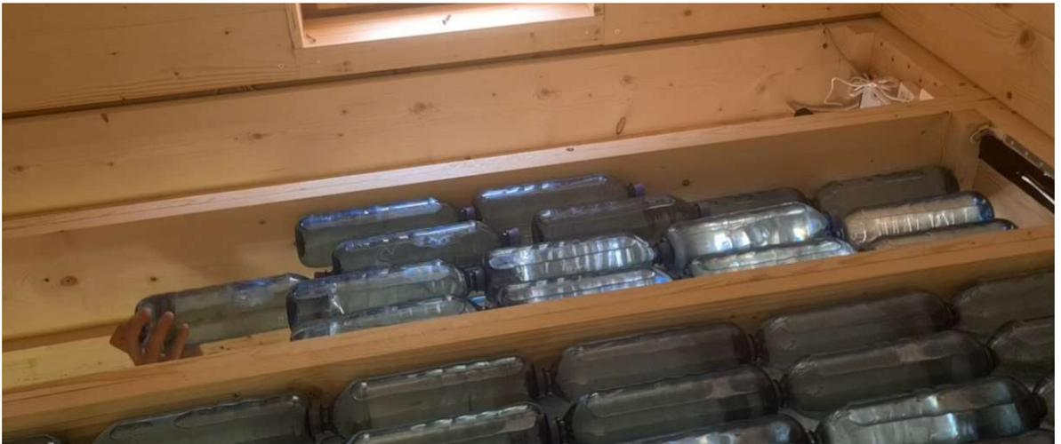
Abb. 194: Befüllen der Speicherdecke mit gefüllten Vöslauer Mehrweg PET-Flaschen
