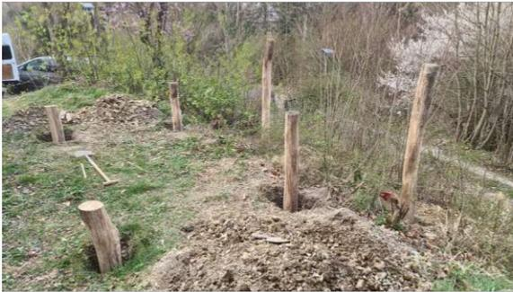
Abb. 134: eingesetzte Fundamentpfähle
