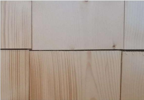
Abb. 203: Fugen zwischen Innenverkleidungsmodulen ohne Blendleisten
