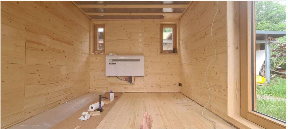
Abb. 197: zwei von drei verlegten Fußbodenmodulen
