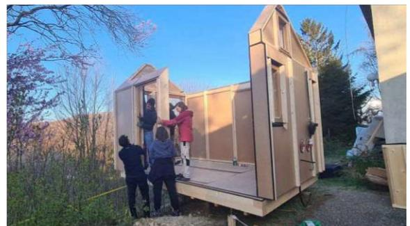
Abb. 145: Montage des Eingangstürmoduls
