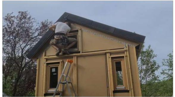
Abb. 160: Montage der Ortgangdeckung
