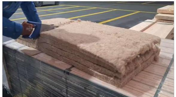
Abb. 80: Zuschnitt der Dämmmatten
