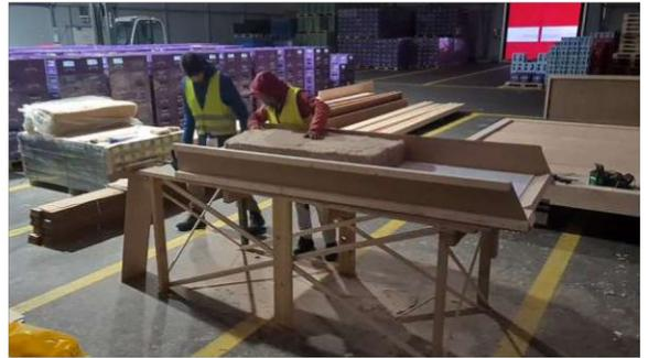
Abb. 90: Dämmen eines Eck-Wandmoduls
