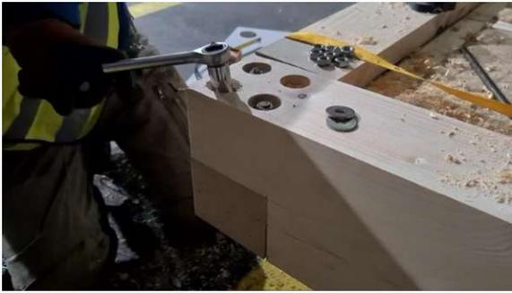
Abb. 85: Verschrauben des Bodenrahmens
