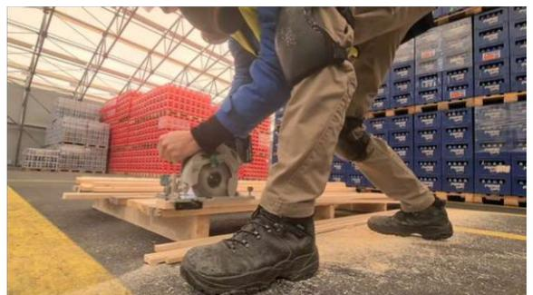
Abb. 76: Zuschnitt von Modulbauteilen
