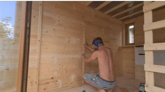
Abb. 205: Montage der Blendleisten
