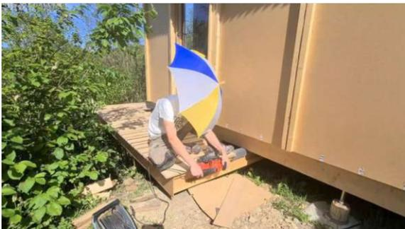
Abb. 169: Schleifen des Steges
