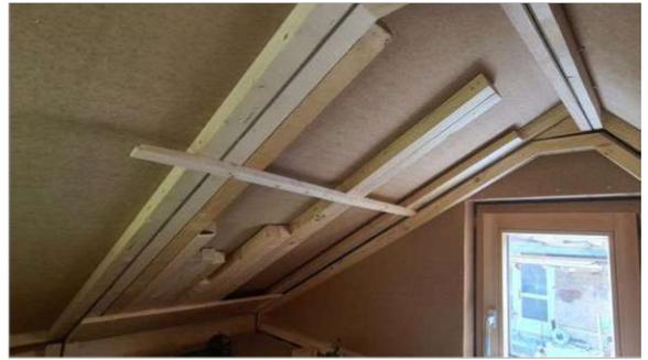
Abb. 189: Lagern der Montagehilfen in der Installationsebene
