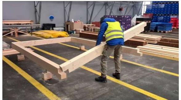
Abb. 75: Zusammensetzen des Bodenrahmens
