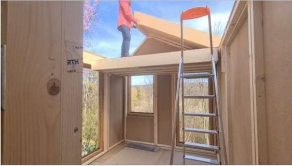
Abb. 148: Montage des ersten Dachmoduls
