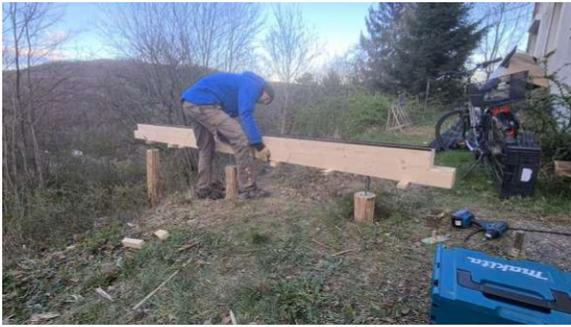
Abb. 138: Montage des Bodenrahmens auf Fundamenten
