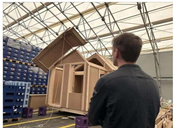
Abb. 116: scheiternder Versuch, die restlichen Dachmodule mittels Kran auf das Haus zu heben
