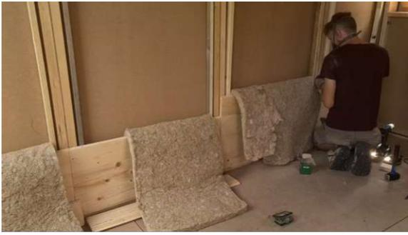
Abb. 187: Innenverkleidungsmodule und Dämmung
