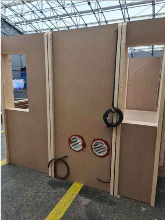
Abb. 95: Module der hinteren Wand: Zwei Fenstermodule und das Technikmodul, inklusive Lüftungsöffnungen
