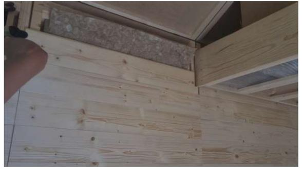
Abb. 188: Einpassen der Innenverkleidung
