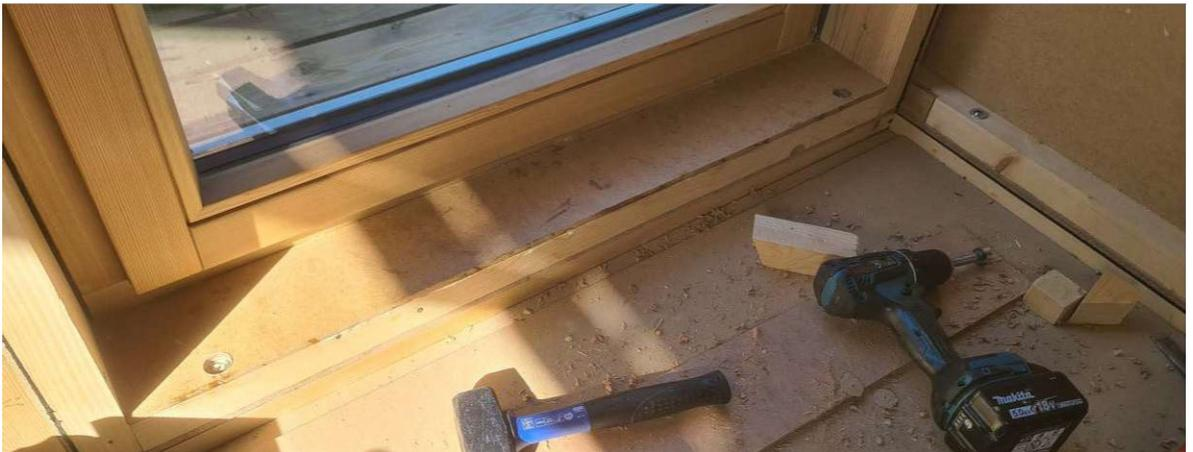
Abb. 186: fertige Unterkonstruktion der Türschwellen
