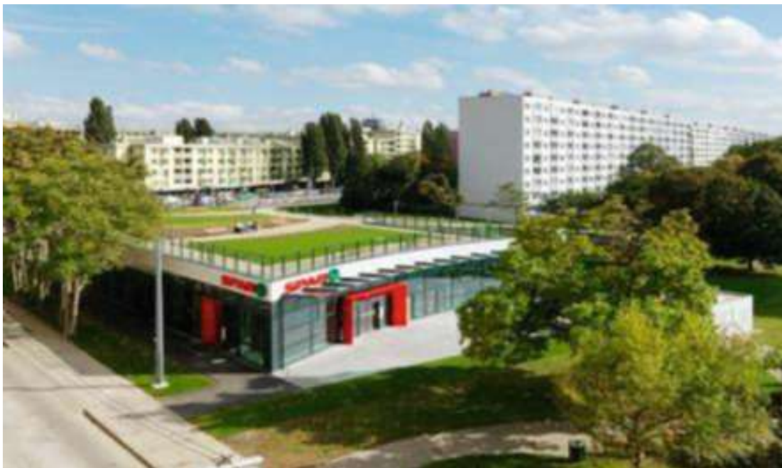
Abbildung 13: SPAR Dach (Quelle: Ott, o.D.)
