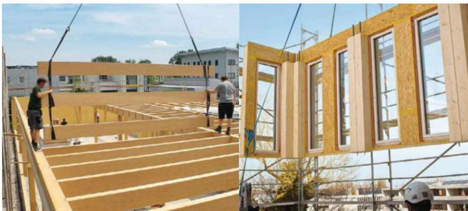
Abbildung 10: Vorfertigung Holzbau (Quelle: Kaufmann et. Al., 2021)
