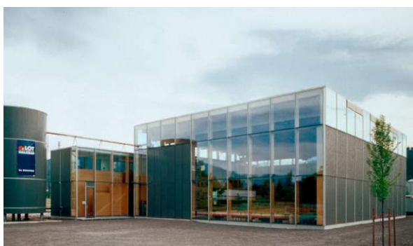
Abb: 50. Produktionshalle, Verwaltung und Silo
