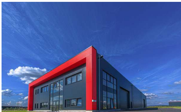
Abb: 40. Produktionshalle mit Büro
