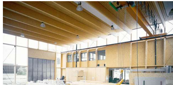
Abb: 53. Tragwerk Produktionshalle
