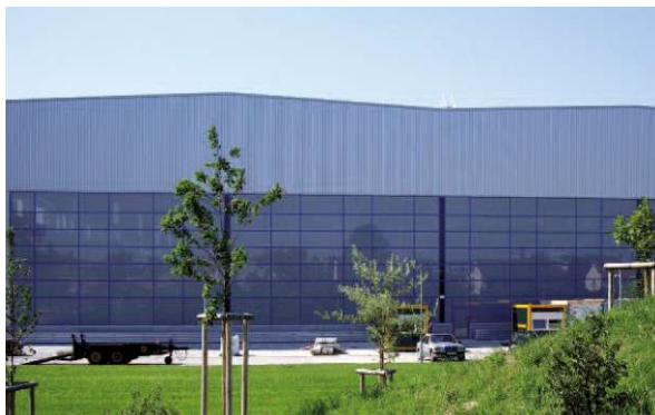
Abb: 55. Ansicht Giebelwand
